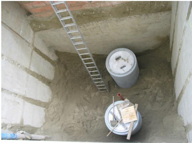
**Abbildung 8.2:** die beiden massiven Fundamente der Versuchsbehälter
