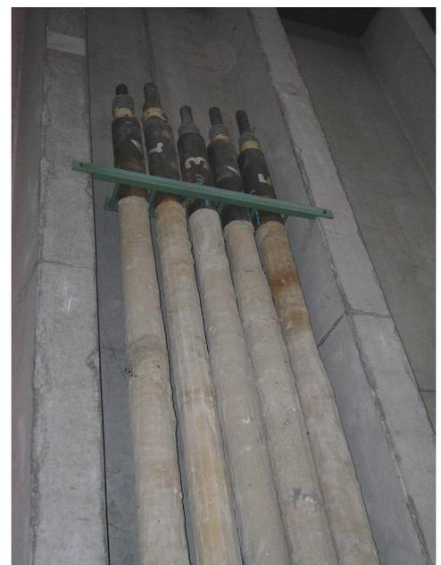
**Abbildung 10.2: Erhöhung der Biegesteifigkeit eines GEWI-Pfahles am Pfahlkopf mit Hilfe eines Stahlrohres**
