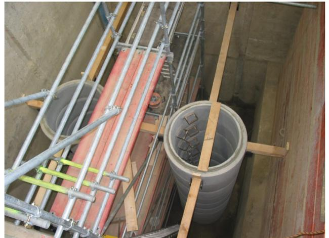
**Abbildung 8.3:** Verstrebung aus Kanthölzer und in der Mitte aufgebaute Arbeitsplattform
