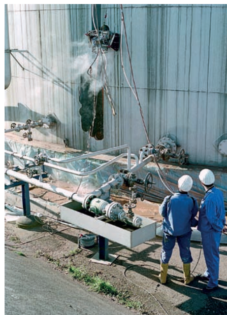
Der ferngesteuerte Magnet-Crawler strahlt in 1 Minute eine 30 cm breite und 10 m hohe Bahn komplett ab.
