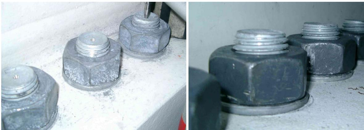
Abbildung 4-46: Schraubengarnituren in Turm 3 mit Weißrost und Turm 1 ohne Korrosion
