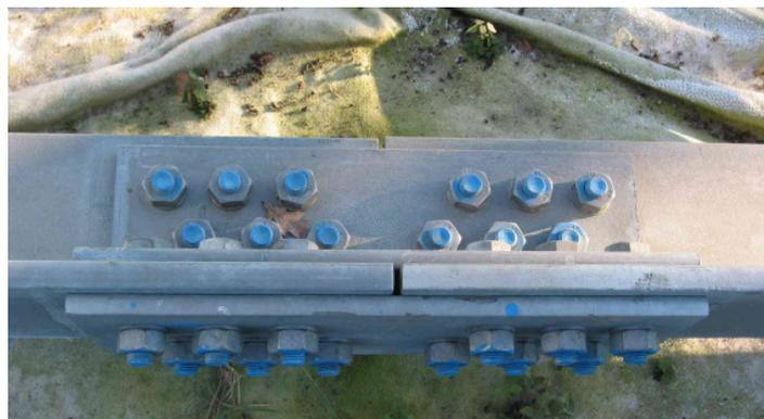
Abbildung 1-2: Gittermast mit scherbeanspruchten GV-Verbindungen
