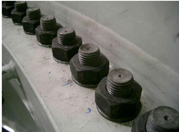
Abbildung 1-1: WEA mit innen liegendem geschraubten L-Ringflansch
