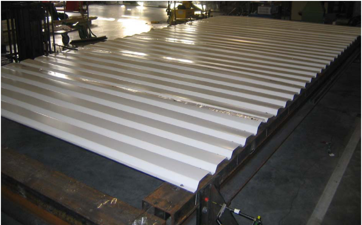
Bild 4: eingedeckter Schubrahmen mit Trapezblech unter zweiseitiger Lagerung
