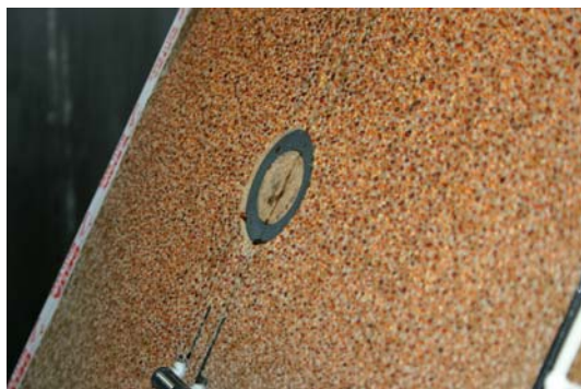
Abbildung 30: Kondenswasserbildung auf der Außenbeplankung von Wand 2 exemplarisch für die Wände 1 bis 5
