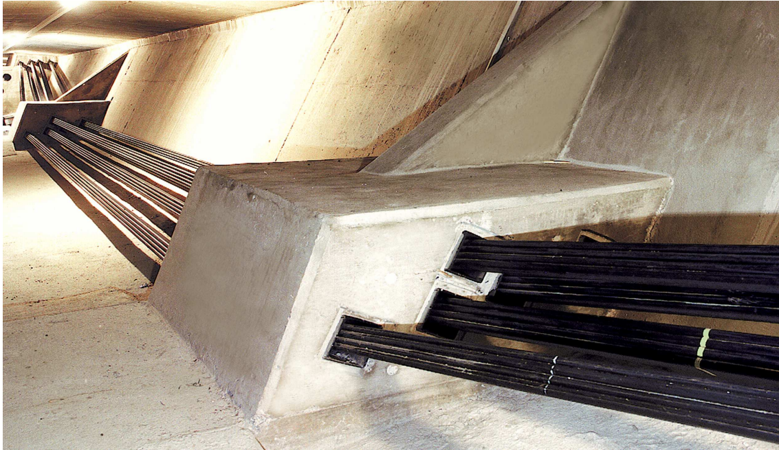
Abbildung 1.4: Umlenkstelle im Inneren eines Hohlkastens [Quelle: Schäfer, Ibbenbüren]
