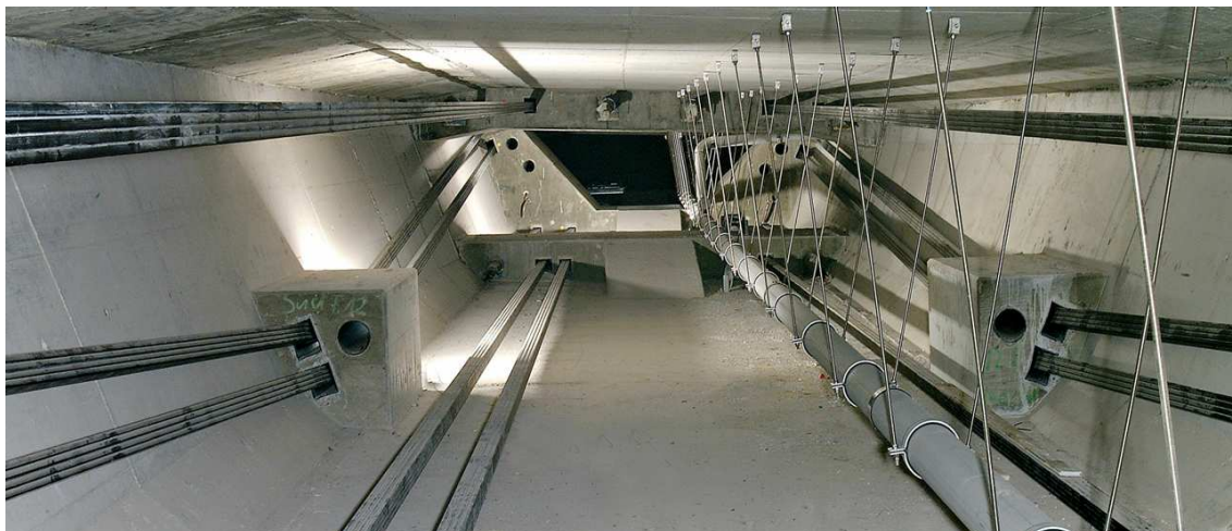
Abbildung 1.3: Externe Bandspannglieder im Inneren eines Hohlkastens [Quelle: VT, Salzburg]
