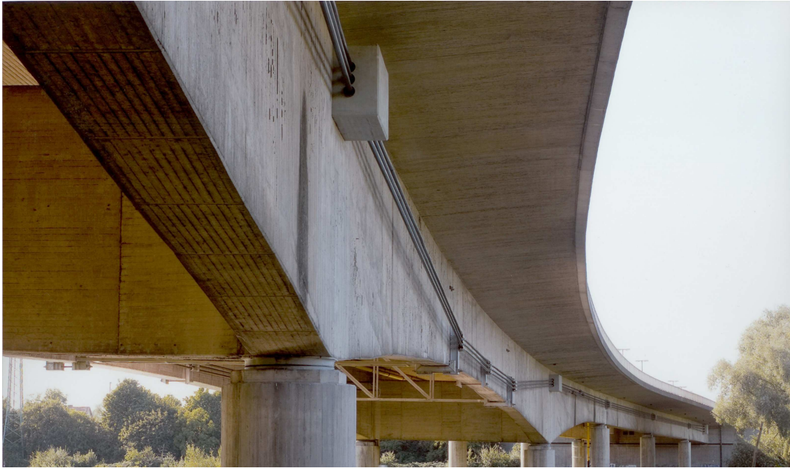
Abbildung 2.14: Verstärkung an der Stegaußenseite [Quelle: SUSPA-DSI, Langenfeld]
