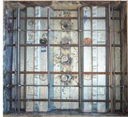
**Bild 3-42** Ansicht und Grundriss des Versuchskörpers P-01 sowie Grundriss kurz vor dem Betonieren [3.1]
