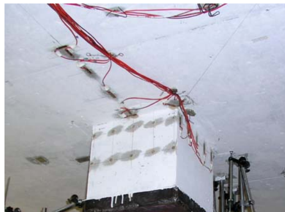
(d) Beton-DMS auf der Plattenunterseite
