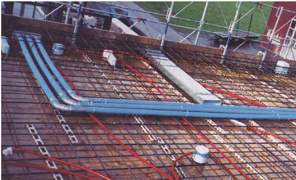
Bild 2-1: Diverse Leitungsführungen in einer Stahlbetondecke
