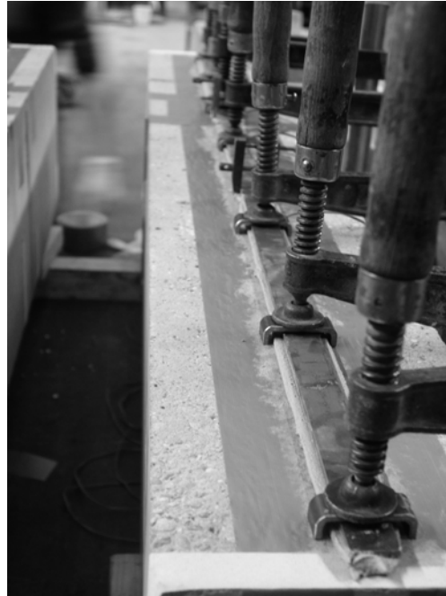
Abb. 3.2: Applikation der Stahllaschen mit Abstandhaltern zur Einstellung definierter Klebschichtdicken
