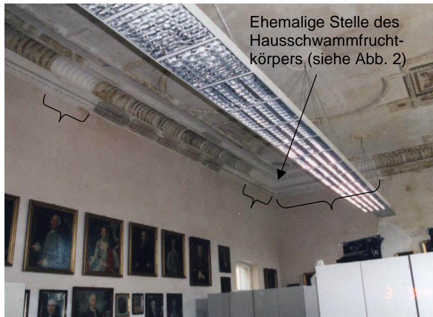
Abb. 5: Deckenansicht nach den Sanierungsarbeiten. Neben den alten Stuckelementen wurden vereinzelt neue Teile (Klammern) eingesetzt. Die Decke konnte zum größten Teil originalgetreu erhalten werden.
