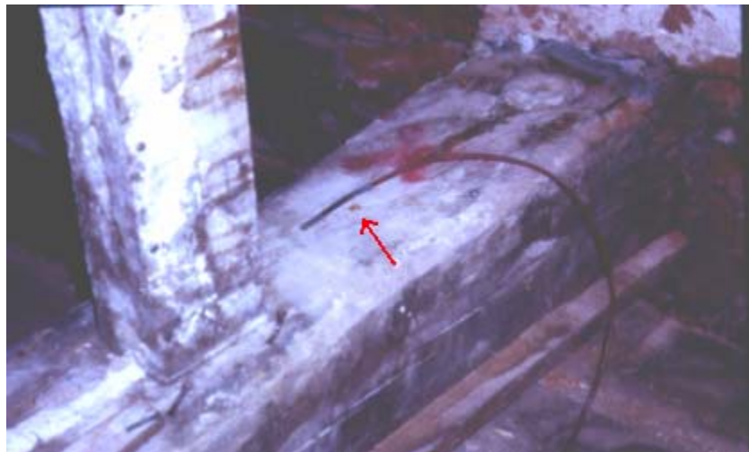
Abb. 5: Temperaturmessfühler vor dem Einsetzen in ein Bohrloch (Pfeil).
