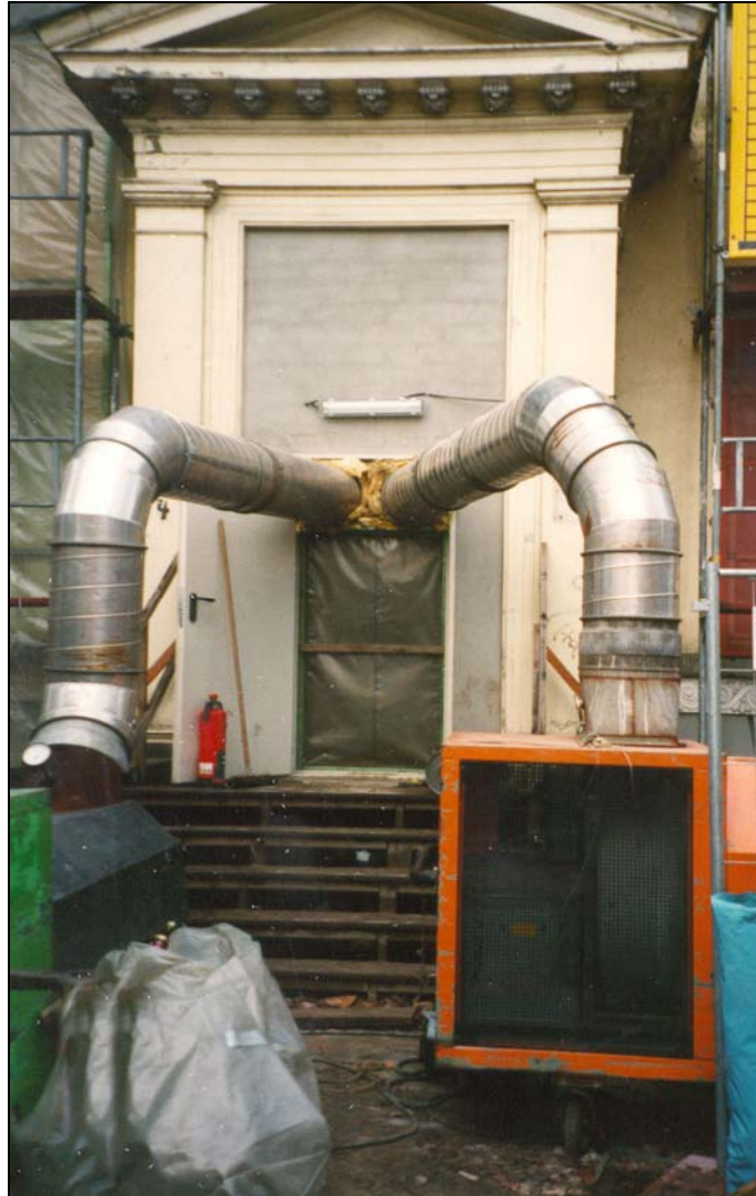
Abb. 5: Ölbrenner mit Zuluftröhren zur Heißluftbehandlung von Abschnitt 1.
