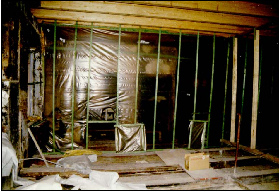
Abb. 7: Abplanung mit Kunststoffbahnen zwischen Abschnitt 1 und 2 im Obergeschoss.
