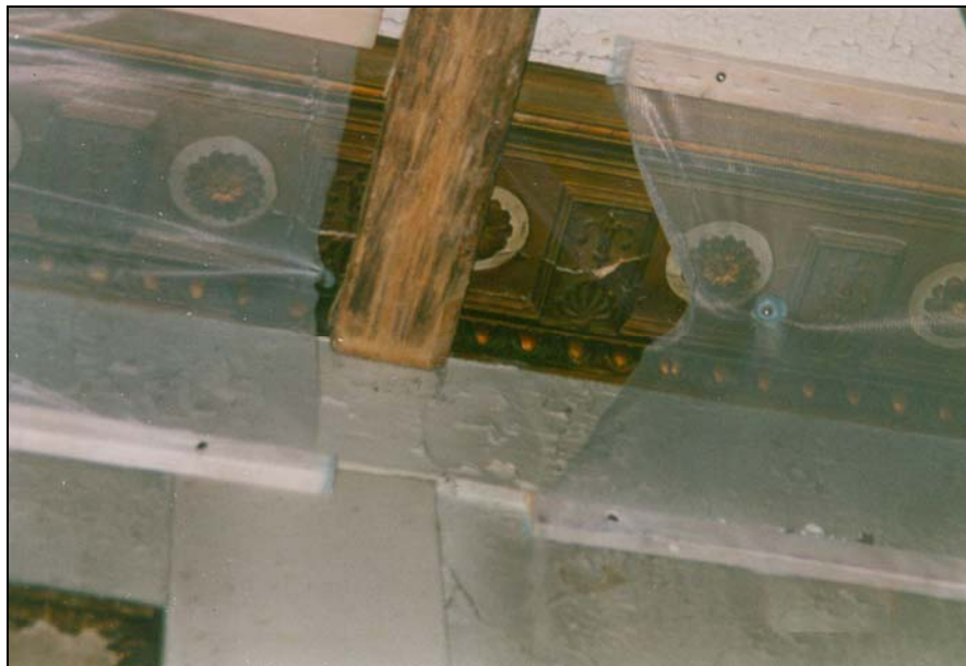
Abb. 4: Stuckkehle im Schinkelsaal; zum Schutz mit Gaze abgespannt.
