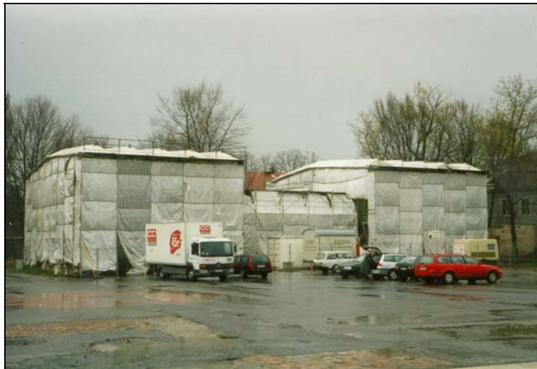
Abb. 4: Pensionshäuser 3 und 4 mit Einhausung zum Witterungsschutz.
