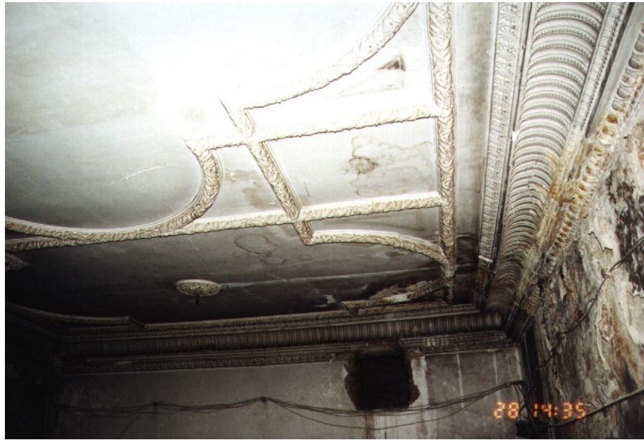
Abb. 1: Gesamtansicht der historischen Stuckdecke im 2. Obergeschoss.
