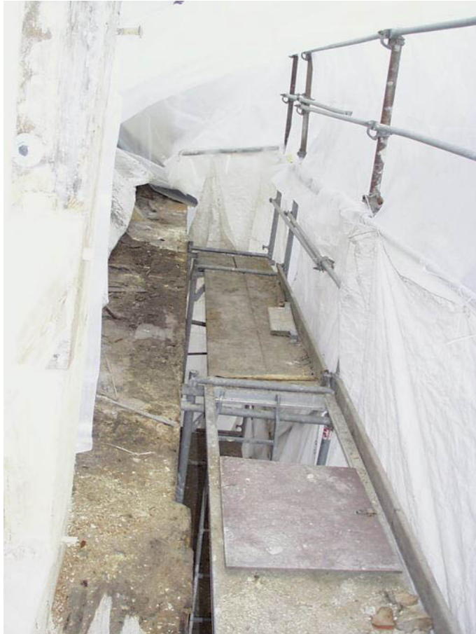
Abb. 7: Eingehauste Rüstung auf der Straßenseite.
