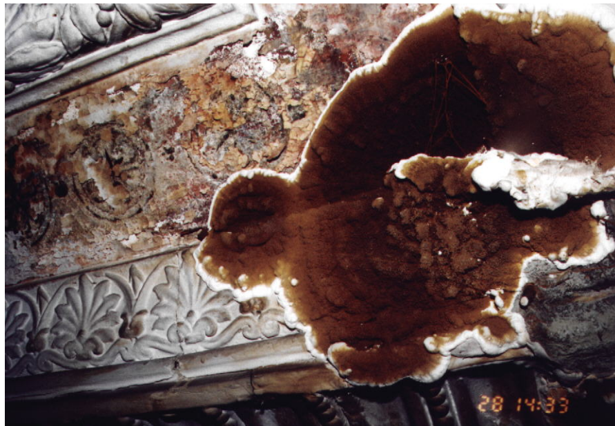
Abb. 2: Frischer, im Wachstum befindlicher Fruchtkörper an der Stuckdecke.
