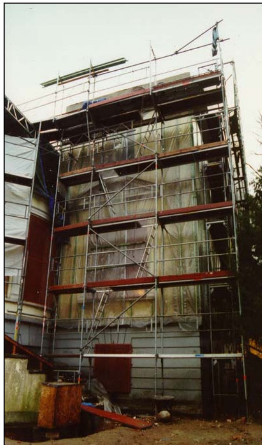
Abb. 6: Einhausung des Abschnitt 1 an der Südwestseite.
