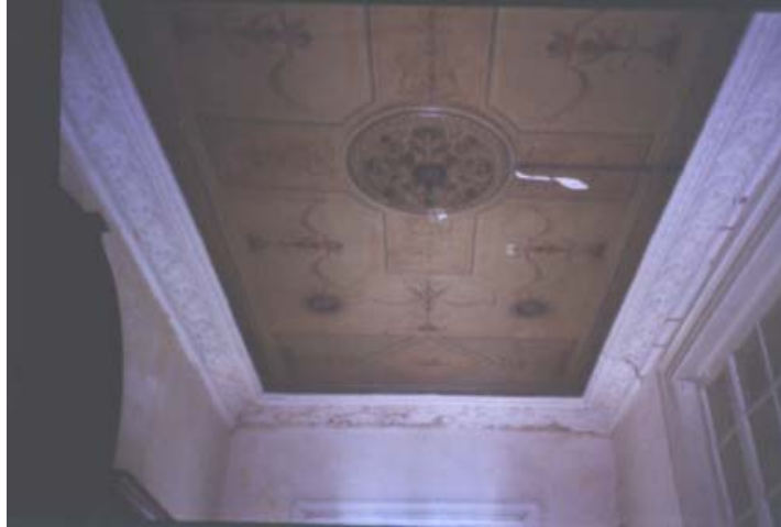
Abb. 3: Denkmalgeschützte Decke mit Jugendstilmalerei.
