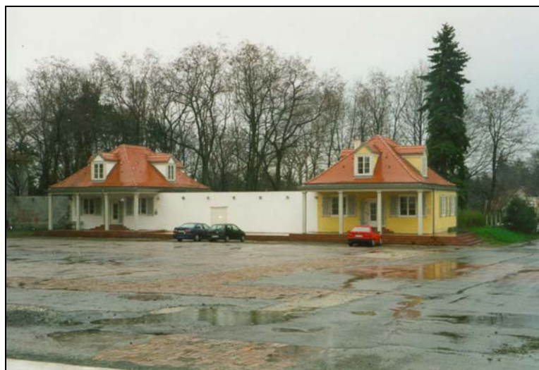
Abb.1: Sanierte und restaurierte Pensionshäuser 1 und 2.
