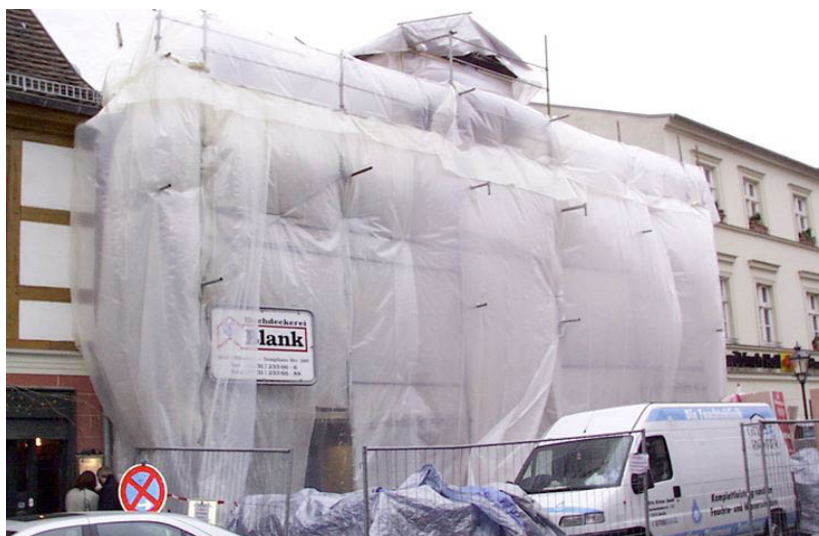
Abb. 6: Straßenseitige Einhausung, aufgenommen während der Beheizung.
