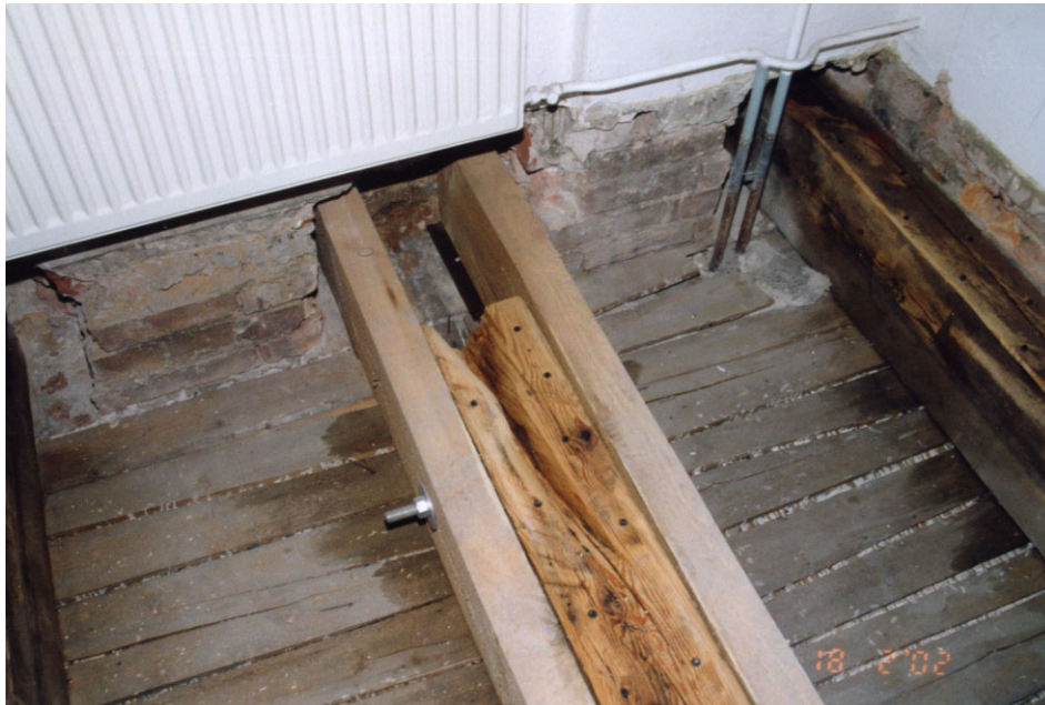
Abb. 4: Fachgerecht bebeitet und gereinigter Deckenbalken mit Injektionspackern und Anlaschungen.
