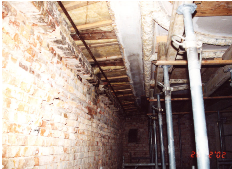
Abb. 3: Demontierter Deckenstreifen im Anschlussbereich zur Außenwand.
