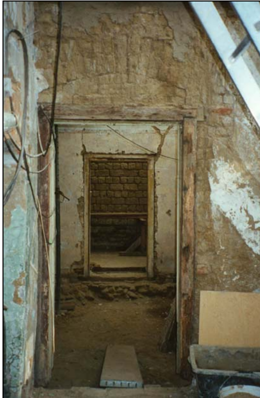
Abb. 1: Gebäudeinneres mit Wänden aus Lehmstrohsteinen.
