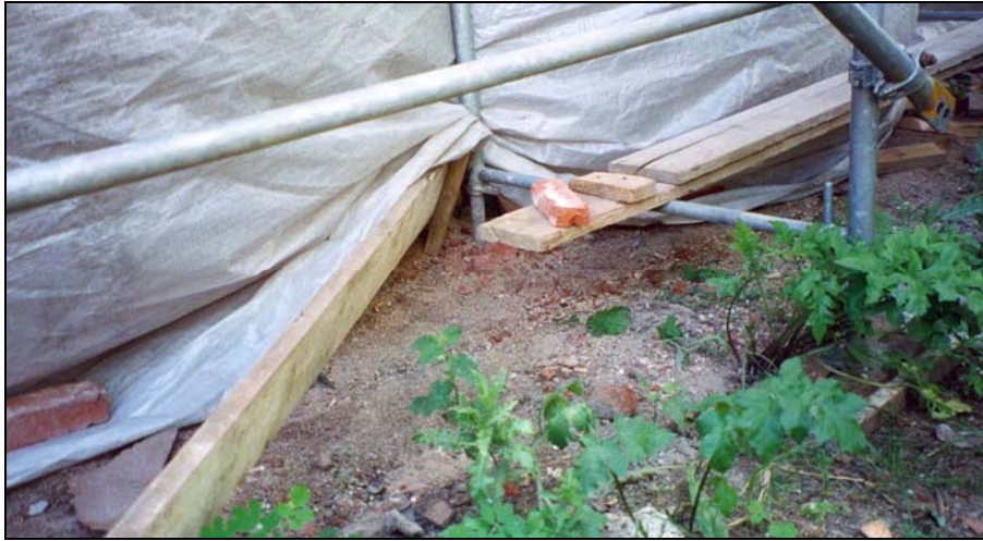
Abb. 6: Öffnung in der Plane zur Abluftsteuerung.
