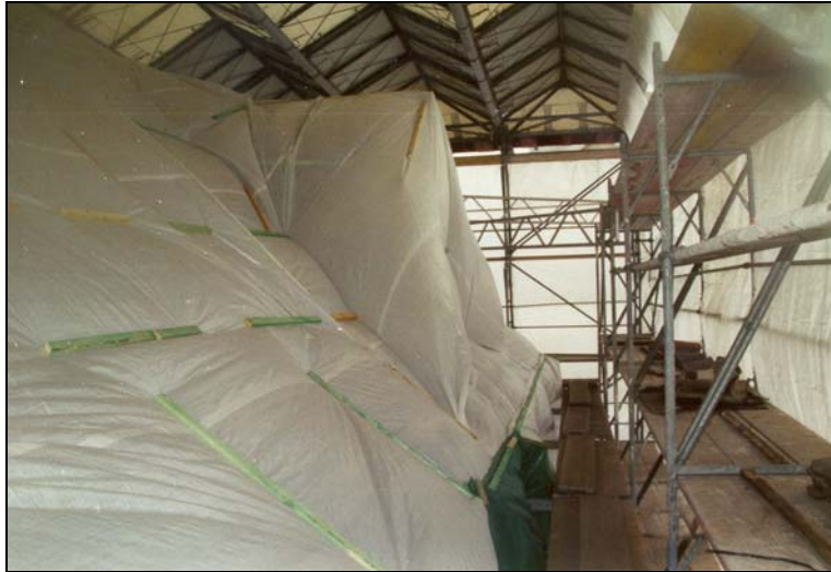
Abb. 5: Separate Dachkonstruktion gegen Witterungseinflüsse und Einhausung der Heißluftbehandlung.
