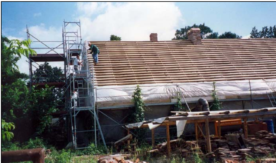
Abb. 5: Kompletteinhausung des Gebäudes.
