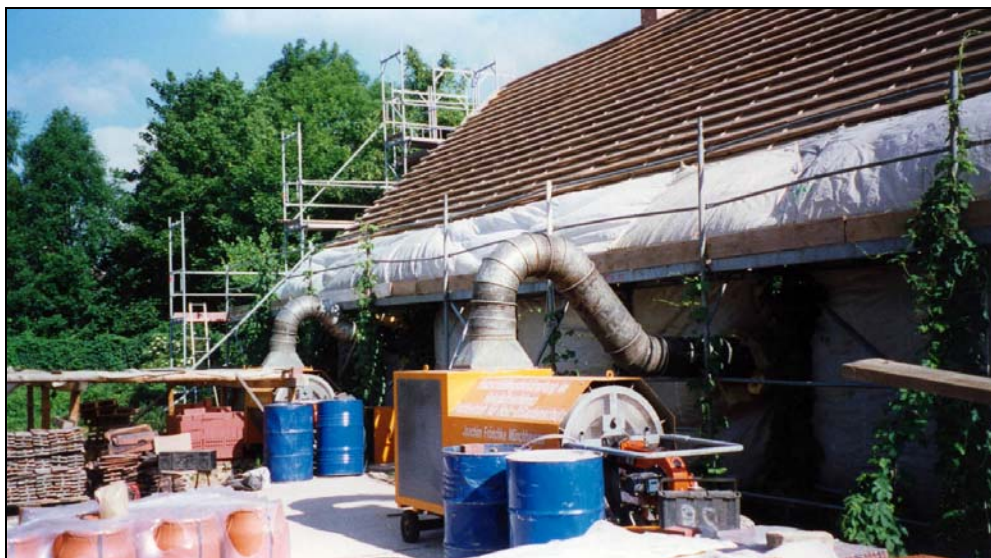
Abb. 7: Einblasen der Heißluft über Zuluftrohre in das Gebäude mit ölbetriebenen Brennern.
