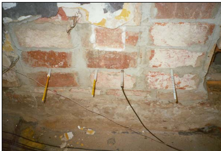
Abb. 8: Elektronische Messfühler und Flüssigkeitsthermometer an einem Messpunkt im Mauerwerk.
