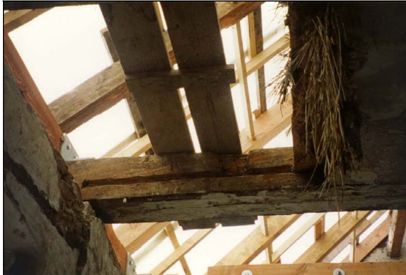
Abb. 3: Freigelegter Deckenbalken. Die Lehmwickeldecke des Dachbodens wurde aus statischen Gründen teilweise abgebrochen und neu eingestakt.
