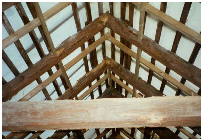
Abb. 2: Blick in den sanierten Dachstuhl mit witterungsfester Abplanung.
