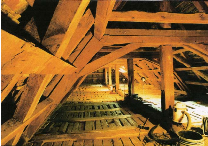
Abb.2: Dachstuhl des Kirchenschiffs - Blick nach Osten. Errichtet 1756 als einseitig nach Osten abgewalmtes Kehlbalkendach mit doppelt liegendem, abgestrebtem Stuhl, Hängesäulen und einem Mittelüberzug über den Deckenbalken. Die Dippel zwischen den Deckenbalken stammen von der Vorgängerkonstruktion des Daches und sind dendrochronologisch auf 1556 datiert.
