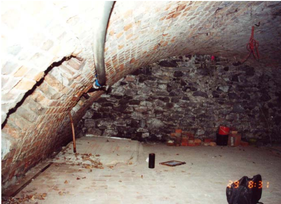
Abb. 2: Blick in das Tonnengewölbe mit den beiden Kellerlichtschächten.
