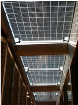
Abb. 6.2.: Integration Photovoltaikanlage in Dach und Fassade. Quelle: FG ee
