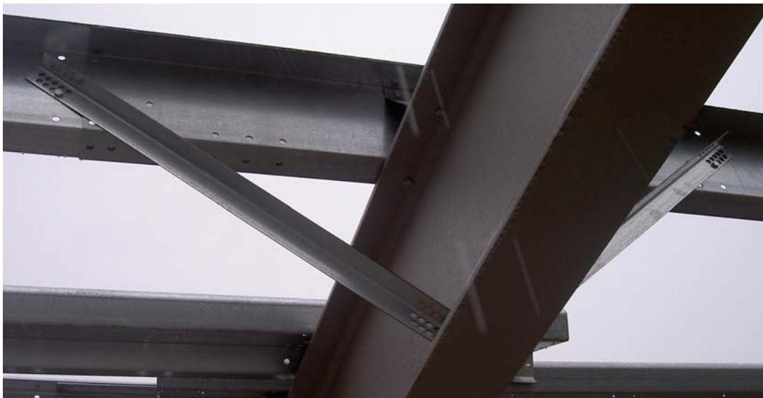
Bild 3.10 Verbindung von Pfette und Flanschstrebe in der Realität
