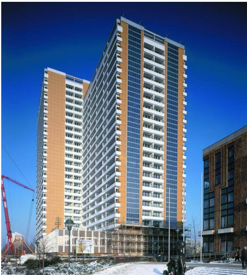
Abbildung 44 PV-VH-Fassade am Wohnhochhaus Helene-Weigel-Platz in Berlin mit polykristallinen PV-Modulen. Die auf der Vorderseite sichtbaren Glashalteleisten als linienförmige Befestigung und die breiten weißen Modulränder bewirken eine auffällige Rasterung der PV-Fläche.
