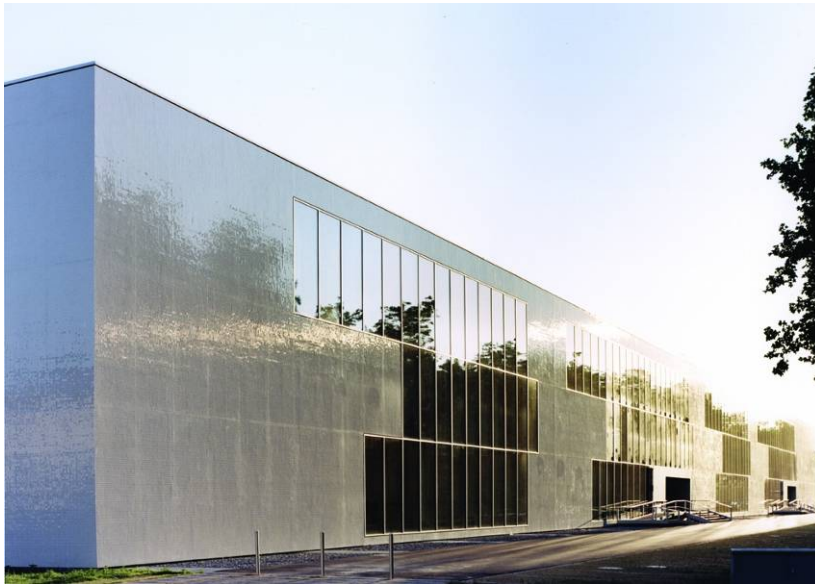
Abbildung 2 VH-Fassade mit irisierenden Glas-Kompositelementen (rückseitig befestigt) am Dienstleistungs- und Service-Center der GEWOGE, LUWOGES BASF GmbH in Ludwigshafen. Architekten: Allmann Sattler Wappner
