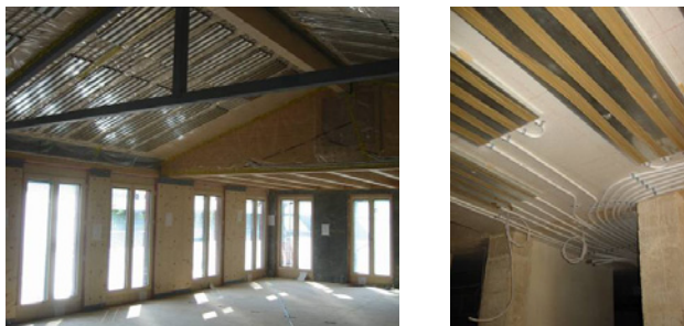
Bild 5-5: Thermoaktive Bauteilsysteme in Decken- und Wandausführung.
