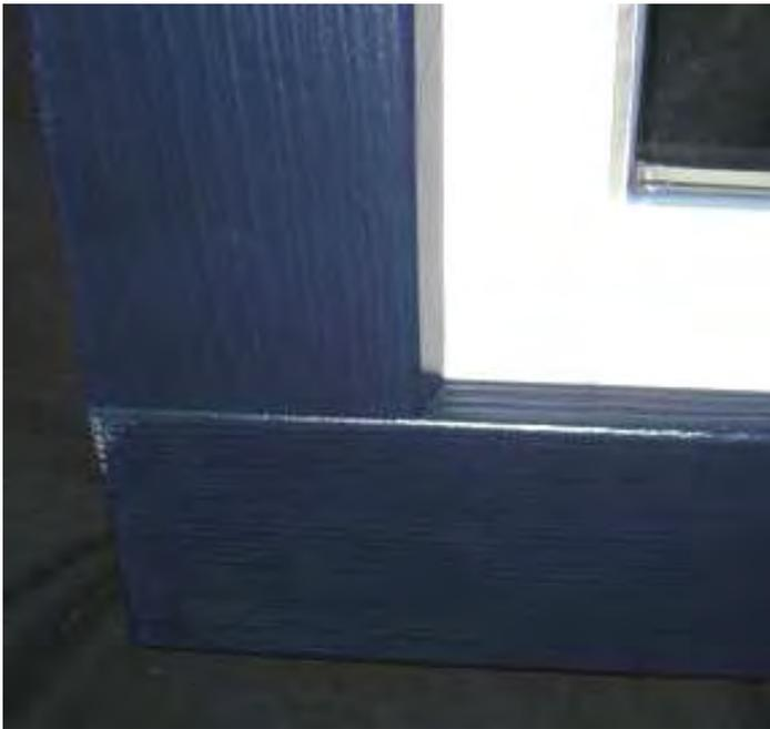
**Abbildung 70** Konstruktionsdetail Musterfenster mit PermaSkin® Folienbeschichtung des Projektpartners BASF
