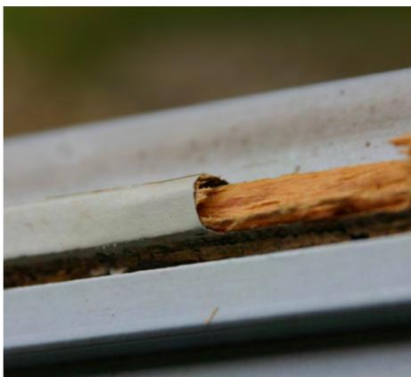
**Abbildung 8** Holzfensterprofil mit Dickschichtlasur, zerstörte Holzsubstanz unter dem intakten Beschichtungsfilm
