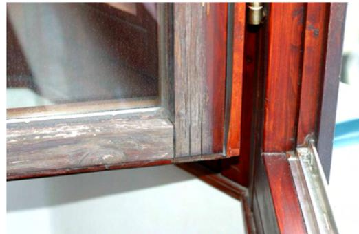
**Abbildung 12** Holzfenster nach jahrelanger Bewitterung ohne Pflege: geschützte Bereiche des Profils im Falz mit intakter Beschichtung
