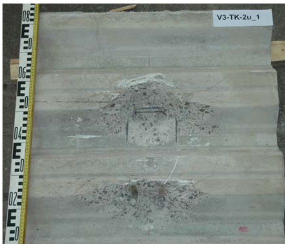
Bild 7-15: Innenansicht des Betongurts 1 von V3-TK-2u
