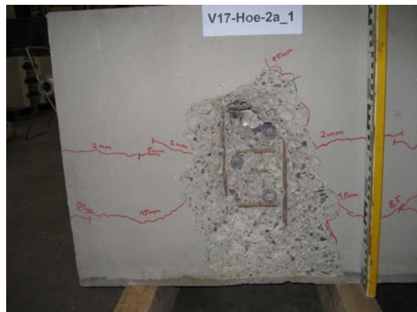
Bild 7-101: Ansicht Betongurt V17-Hoe-2a Seite 1
