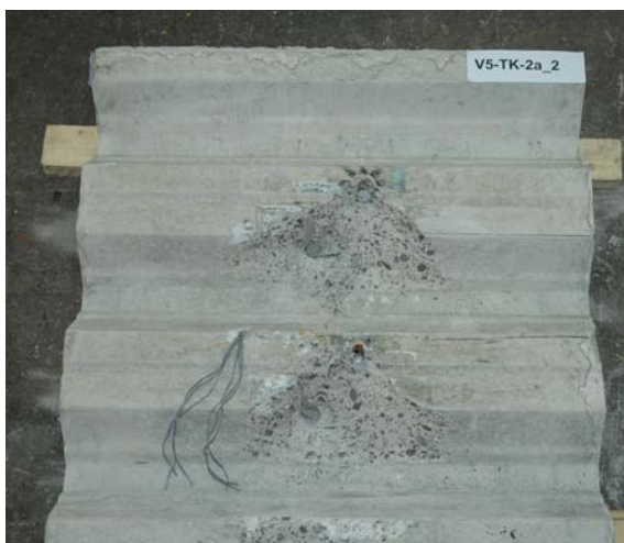
Bild 7-30: Innenansicht des Betongurts 2 von V5-TK-2a
