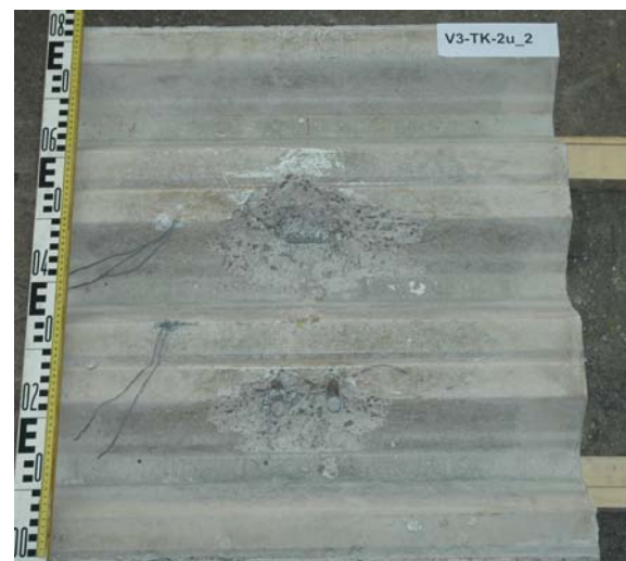
Bild 7-16: Innenansicht des Betongurts 2 von V3-TK-2u
