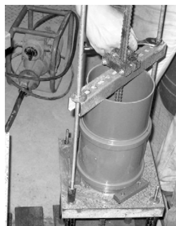
e) Aufsetzen des 2. Segments
