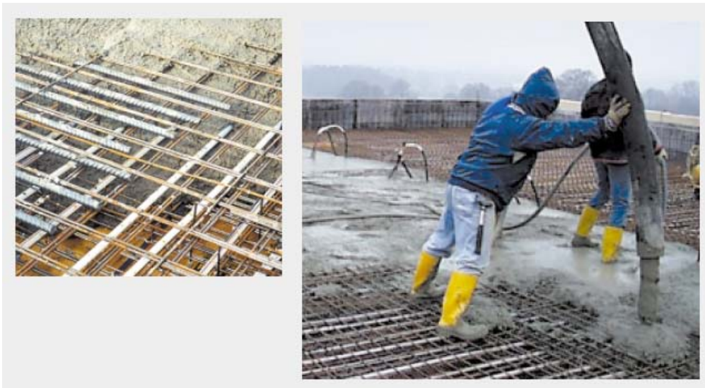
Bild 2-1 links: Rohrleitungen zwischen der Bewehrung, rechts: Einbringen des Ortbetons [4].
