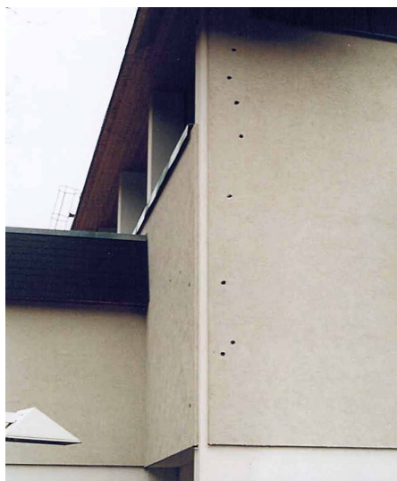
Abb. 5: Spechtlöcher sind auch in den Fassadenflächen möglich. (Bild: Falke)
