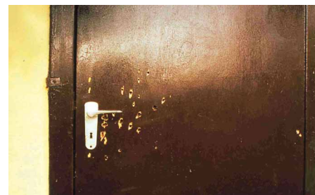
Abb. 6: Selbst die Holztüre eines Wochenendhauses kann einem Specht als vermeintliche Quelle für Futter erscheinen. (Bild: Landesanstalt für Umweltschutz Baden-Württemberg)
