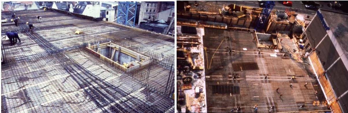
**Bild 2-1: Ausführungsbeispiele vorgespannter Flachdecken mit Stützstreifenvorspannung**
