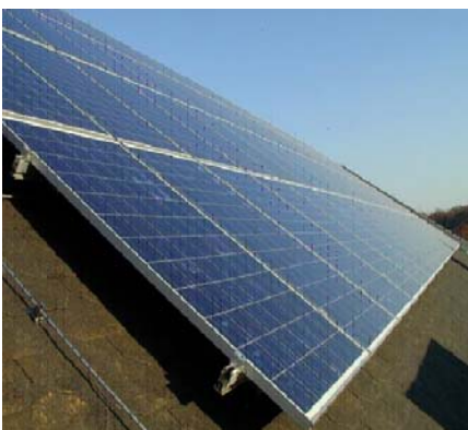
Abb. 20 Aufdachmontage, Quelle: www.energie-umwelt.de/images/PV/Schlo-Dach.jpg (links)
