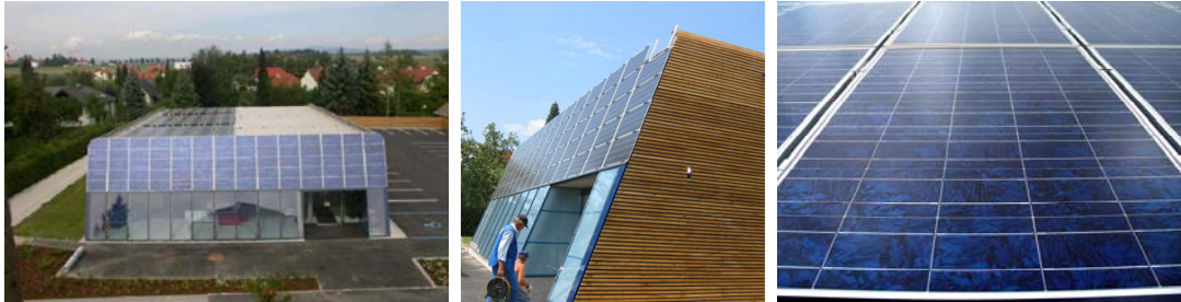
Abb. üPhotovoltaikfassade Ökomarkt, Quelle: www.twoday.net
