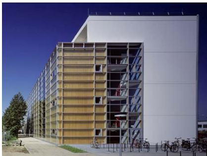
Abb. 127 Südostansicht Institutsgebäude, Verglasung vor massiver Holzwand als Speichermasse, Quelle: www.pfeifer-kuhn.de Abb. 128 Energieschema Sommer und Winter, Quelle: www.pfeifer-kuhn.de
