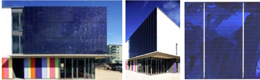
Abb. 47 Südfassade Kinderkrippe und Jugendfreizeitstätte in München, Quelle: www.baunetz.de
