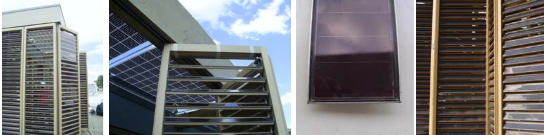
Abb. 62 Lamellenfassade des Betrags der TU Darmstadt zum „Solar Decathlon 2007“, Quelle: FG ee
