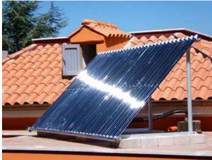
Abb. 97 Vakuumröhrenkollektor | Quelle: www.solarthermietechologie.de
