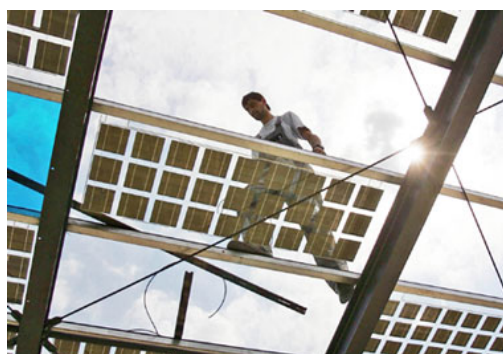
Abb. 23 Auf ein Flachdach aufgeständerte Photovoltaikmodule; Quelle: www.meikowe.de
