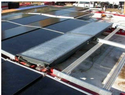
Abb. 112 Solarthermiemodul während des Einbaus, Quelle: FG_ee
