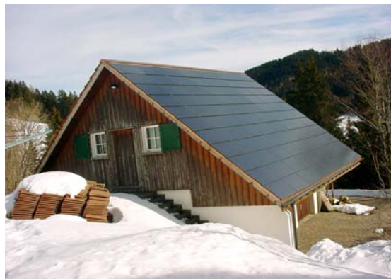
Abb. 20 Aufdachmontage, Quelle: www.energie-umwelt.de/images/PV/Schlo-Dach.jpg (links)
