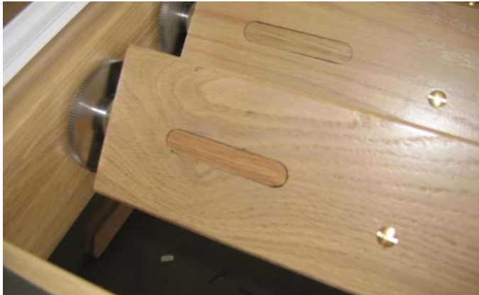
Abb. 154 Lamellenuntersicht mit Fräsung, Quelle: FG_ee
