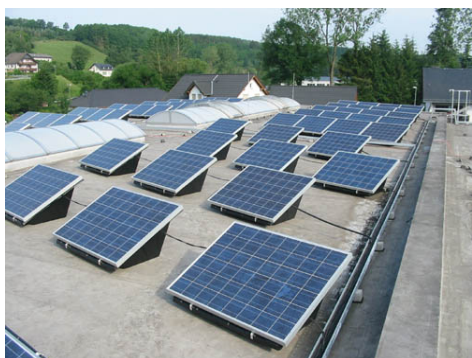
Abb. 23 Auf ein Flachdach aufgeständerte Photovoltaikmodule; Quelle: www.meikowe.de
