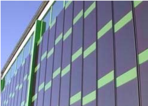
Abb. 25 Solarthermische Fassadenintegration Quelle: www.solid.de
