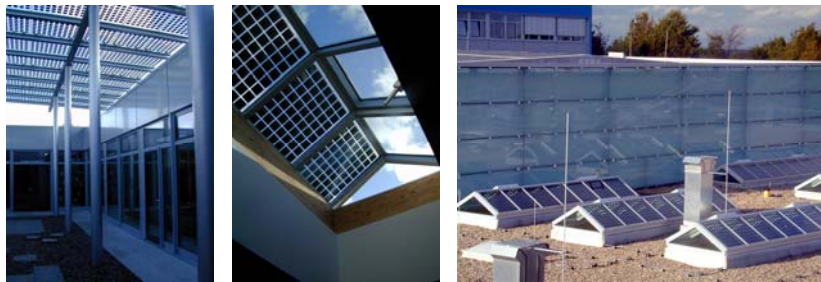
Abb. 55 Semitransparente PV-Module in der Überdachung des Atriums, Quelle: Raumplan Architekten
