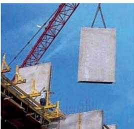
Stahlbetonfertigteile für Wände
