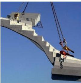
Stahlbetonfertigteile für Treppen
