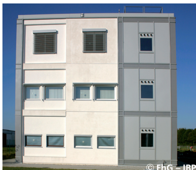
Bild 1: Versuchsfassade an der Ostseite des VERU-Versuchsgebäudes
