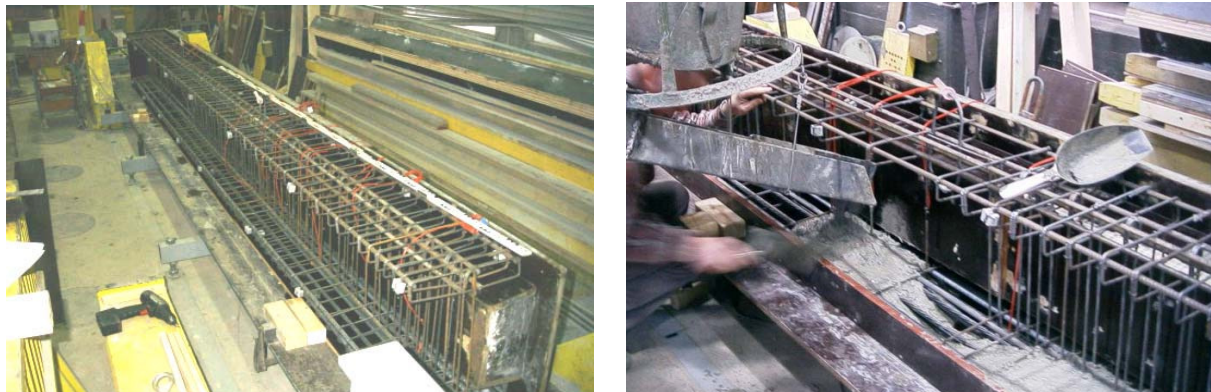
Bild 5.9: Bewehrungskorb im Spannbett (links) und Betonieren des Untergurtes (rechts)
