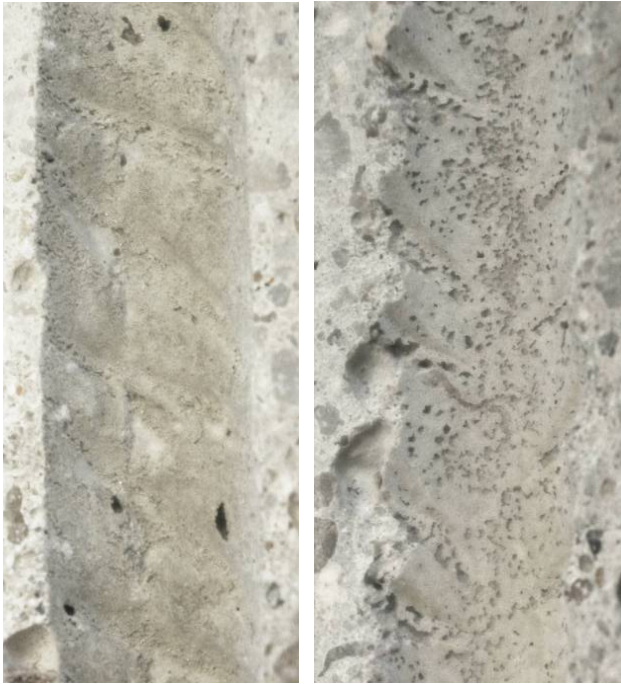
Abb. 32: Schnitt durch einen Probekörper mit chromatreduziertem Beton CEM I; links: nach Entfernung des verzinkten Stahls; rechts: nach Entfernung des Stahls
