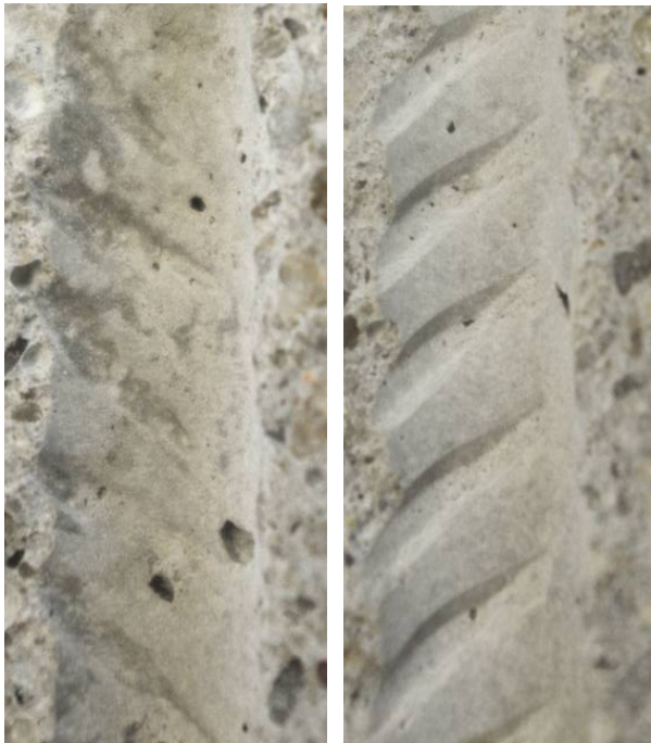
Abb. 31: Schnitt durch einen Probekörper mit chromathaltigem Beton CEM I*; links: nach Entfernung des verzinkten Stahls; rechts: nach Entfernung des Stahls
