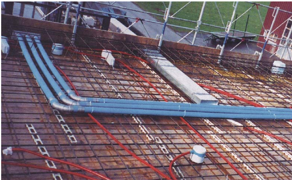
Bild 2-1: Diverse Leitungsführungen in einer Stahlbetondecke
