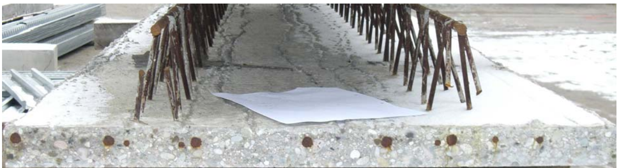
Bild 5-3: Querschnitt Elementplatte 2
