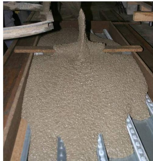
**Abb. 2- 8:** Einbau des selbstverdichtenden Leichtbetons SVLB-1 auf ein Verbundblech
