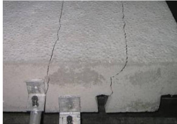
**Abb. 2- 10:** Längsrissbildung an einer Leichtbeton-verbunddecke hervorgerufen durch die Aufspreizung der Obergurtflanken unter Biegebeanspruchung
