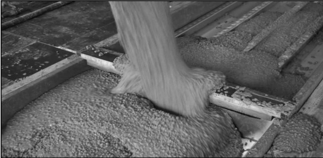
**Abb. 2- 21:** Einfüllen des Leichtbeton mit Hilfe einer mobilen Betonpumpe.
