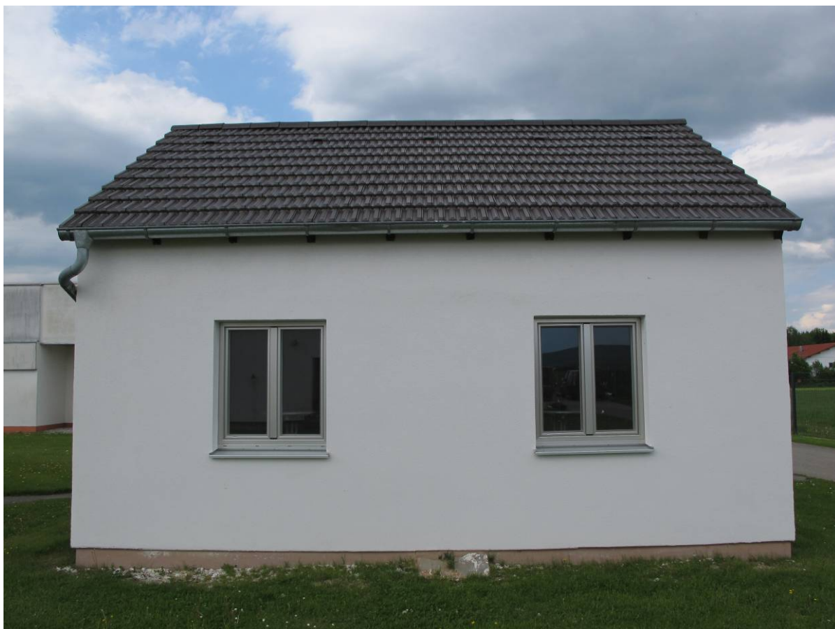
Abb. 62: Versuchsgebäude mit zwei identischen Räumen am IBP-Standort Holzkirchen
