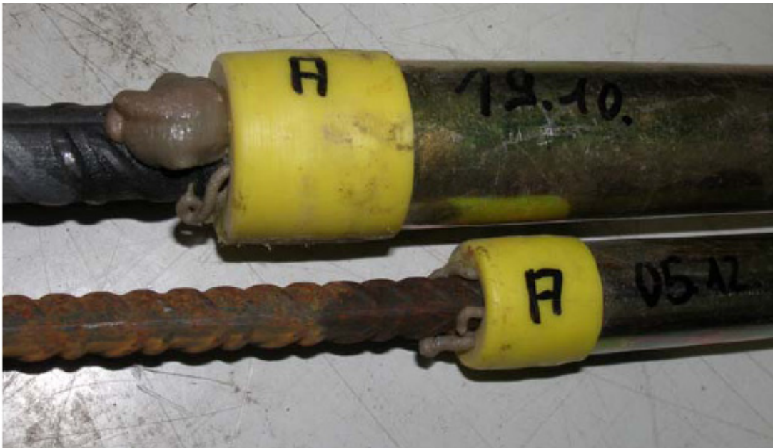
Bild 36: Mörtelaustritt aus den Entlüftungsöffnungen nach erfolgreichem Verpressen.
