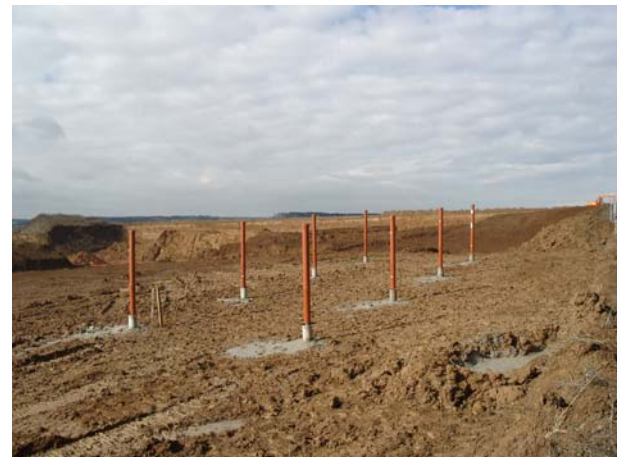
Abbildung 3.11: Versuchsfeld nach Pfahlherstellung, Schutz der Stähle mit KG-Rohren
