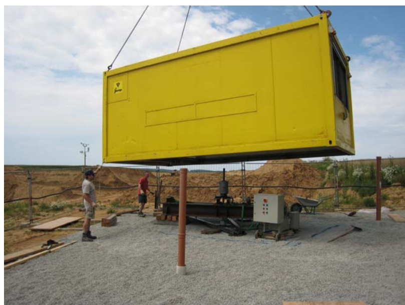
Abbildung 3.16: Schutz des Versuchsaufbaus mit Baucontainer
