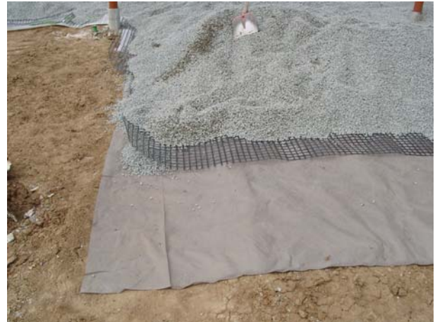
Abbildung 3.14: Dreischichtaufbau Arbeitsplanum
