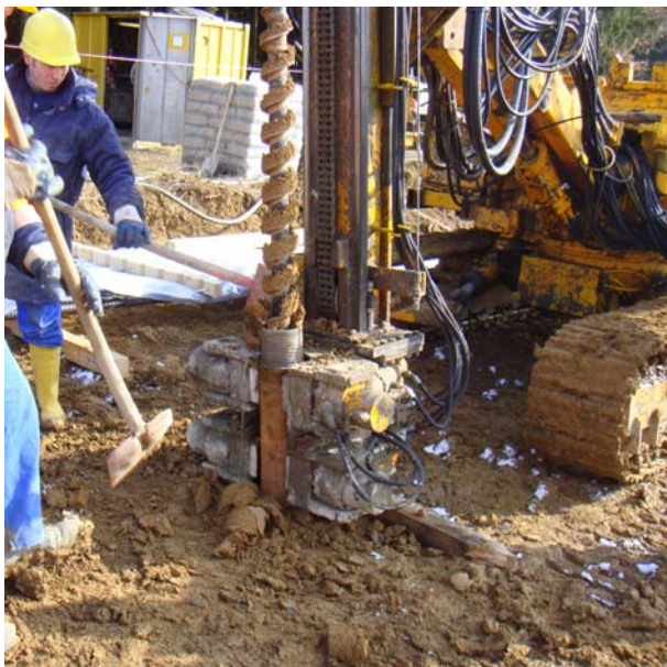
Abbildung 3.8: Bohren mit Außenverrohrung und Schnecke
