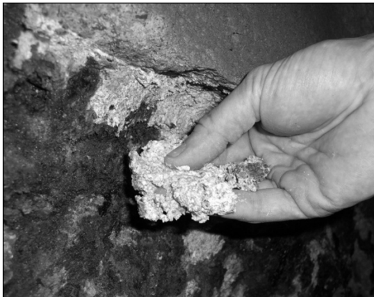
Bild 14: Thaumasitbildung im Beton bei Kontakt mit eisendisulfidhaltigem Boden
