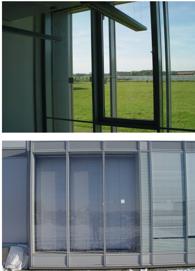
Bild 3: Innen- und Außenansicht (mit geschlossenem Behang) Versuchsraum EG-M1.
