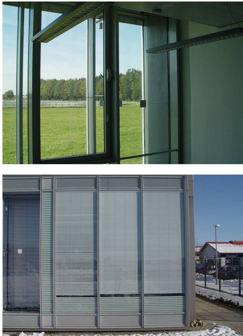
Bild 4: Innen- und Außenansicht (mit geschlossenem Behang) Versuchsraum EG-S1.
