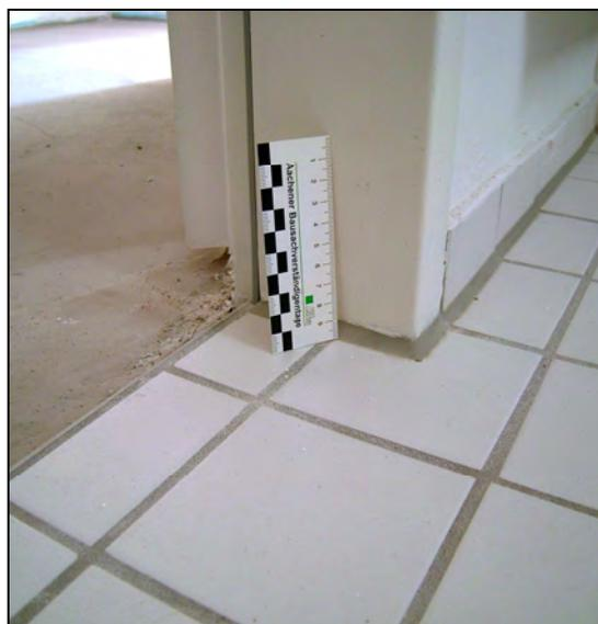
**Abb. 3.5.3-2:** Übergang Bad/ Flur, im Flur ist noch keine Nuttschicht verlegt**Begehung:** 09/ 2008
