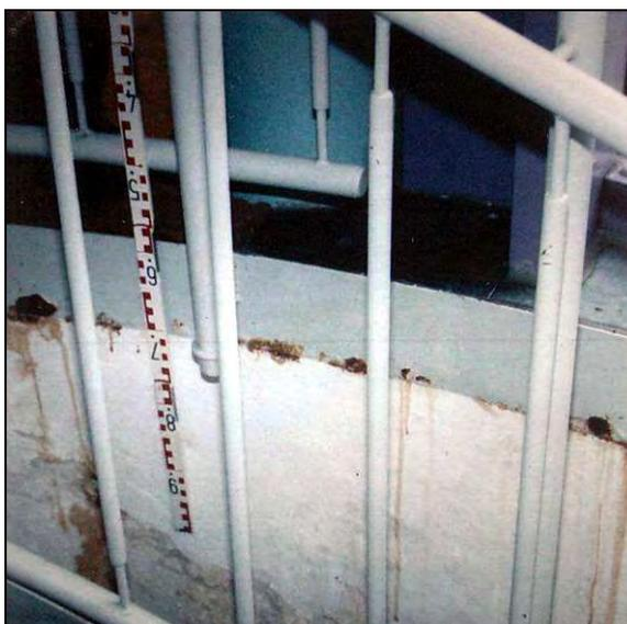
**Abb. 2.3.2-4:** Schäden im Bereich des Hauseingangs am Treppenabgang
