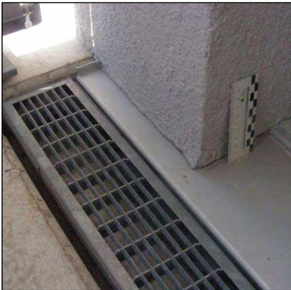
**Abb. 2.5.2-9:** Übergang Entwässerungsrinne/Türanschluss
