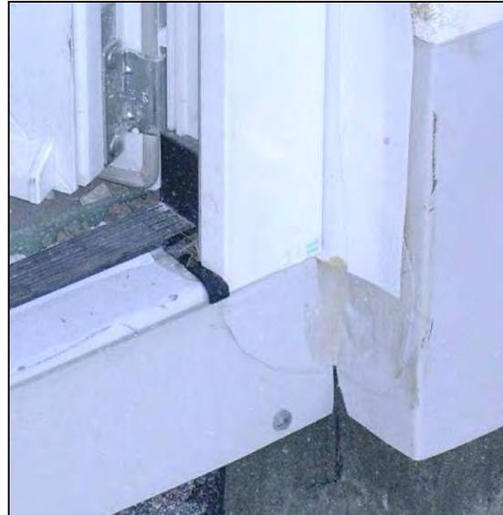
**Abb. 2.5.8-2:** Detail Ausführung Verbundblech im Bereich der Leibung
