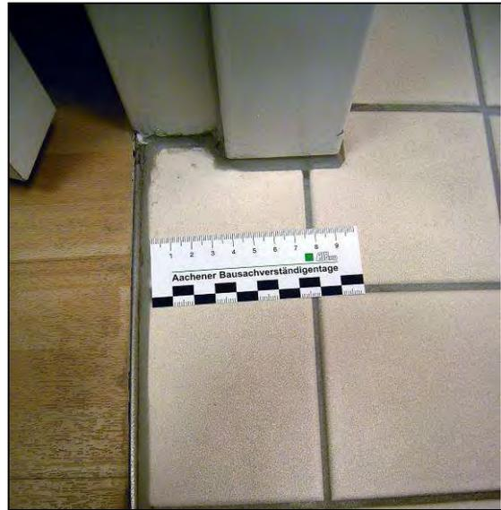
**Abb. 3.3.1-2:** Leichte Durchfeuchtungsschäden am anschließenden Parkettboden
