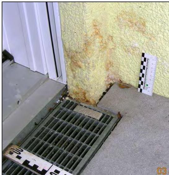
**Abb. 2.3.1-2:** Balkonschwelle (nicht niveaugleich)**Begehung:** 03/2008**Schadensbild:** Feuchtigkeitsschäden am Wärmedämmverbundsystem**Abb. 2.3.1-3:** Prinzipskizze, Detailschnitt im Bereich des mangelhaften Balkonanschlusses
