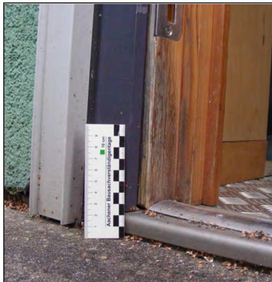
**Abb. 2.3.5-2:** Die Rahmenstiele der Holztür sind bereits durch Feuchtigkeitseinwirkung zerstört.**Begehung:** August 2008
