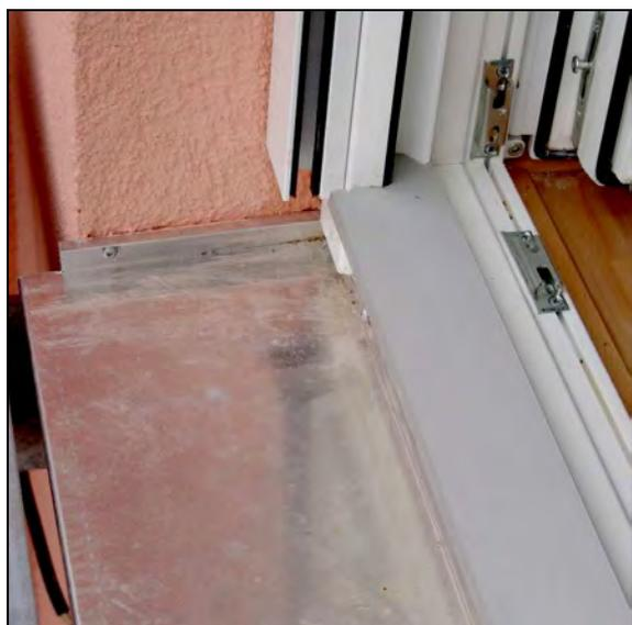
**Abb. 2.5.7-4:** Anschluss Balkon/ Fenstertür
