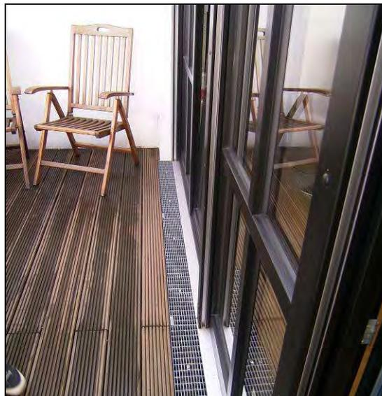
**Abb. 2.5.3-2:** Anschluss Balkon
