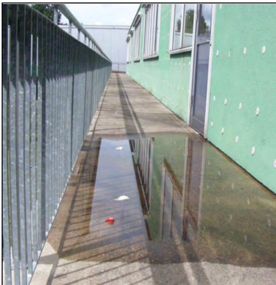
**Abb. 2.3.5-1:** Pfützenbildung auf dem Balkon**Baujahr:** 2001**Lage der untersuchten Schwellen:**
