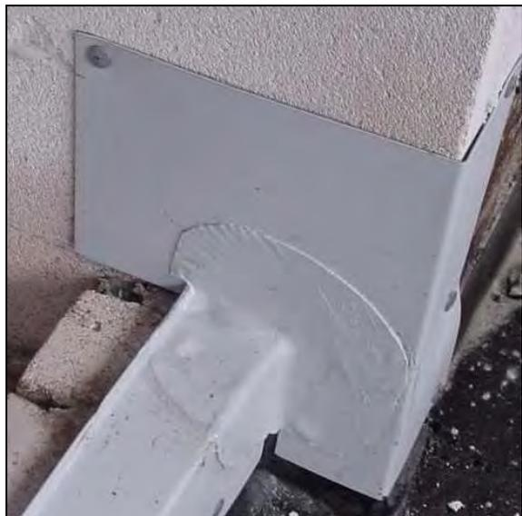
**Abb. 2.5.8-4:** Lage Verbundblech vor Einbau der Türanlage
