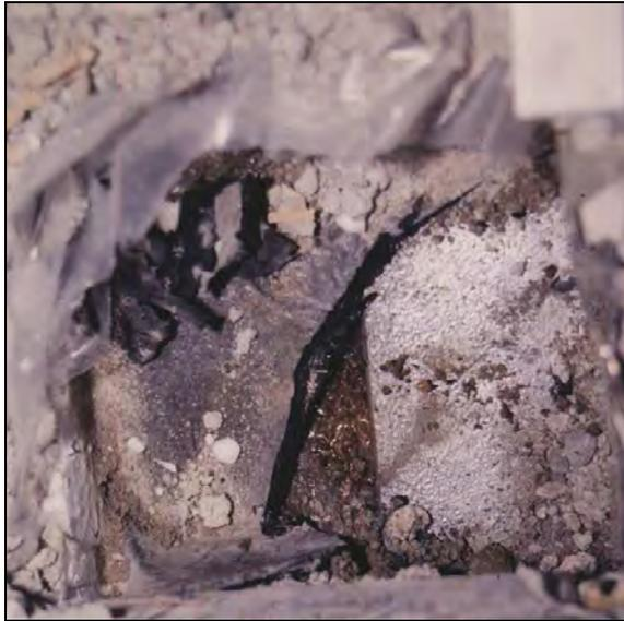
**Abb. 3.3.3-4:** Aufkantung der Abdichtung im Bereich der Türzarge
