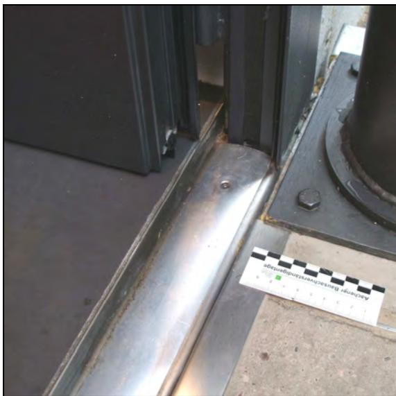
**Abb. 2.6-6:** Türschwelle im eingebautem Zustand
