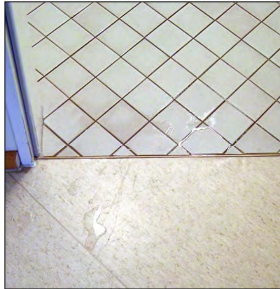
**Abb. 3.5.1-2:** Feuchtigkeitsbeanspruchung der Schwelle
