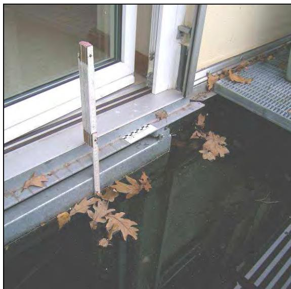
**Abb. 2.5.1-4:** Anschlusssituation, bei der Besichtigung wurde der Gitterrost vor der Tür entfernt
