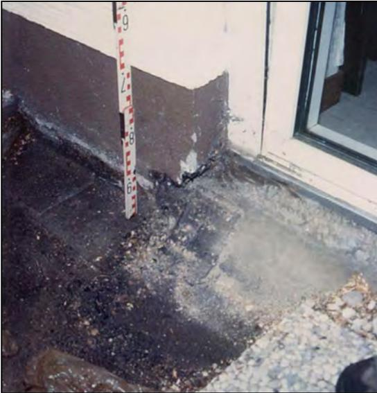
**Abb. 2.3.6-1:** Übersicht zum Türanschluss nach Entfernen des Belags
