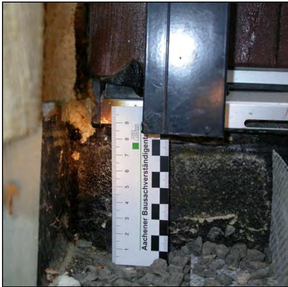
**Abb. 2.3.4-4:** Im unmittelbaren Eckbereich liegt die Flüssigabdichtung auf der Polyurethanausschäumung der Fuge zwischen Türrahmen und Rohbauanschluss auf und ist nach oben hin offen.
