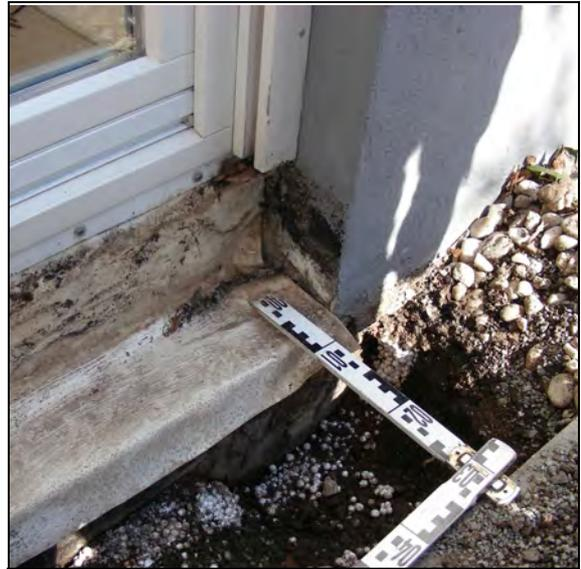
**Abb. 2.3.3-5:** Unzureichende Abdichtungsmaßnahmen am Türanschluss
