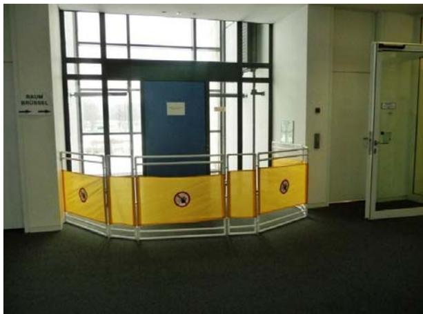
**Bild A5-20: Taktile wahrnehmbare und visuell kontrastierende Absicherung eines temporär gesperrten Bereichs [Foto: Michels]**
