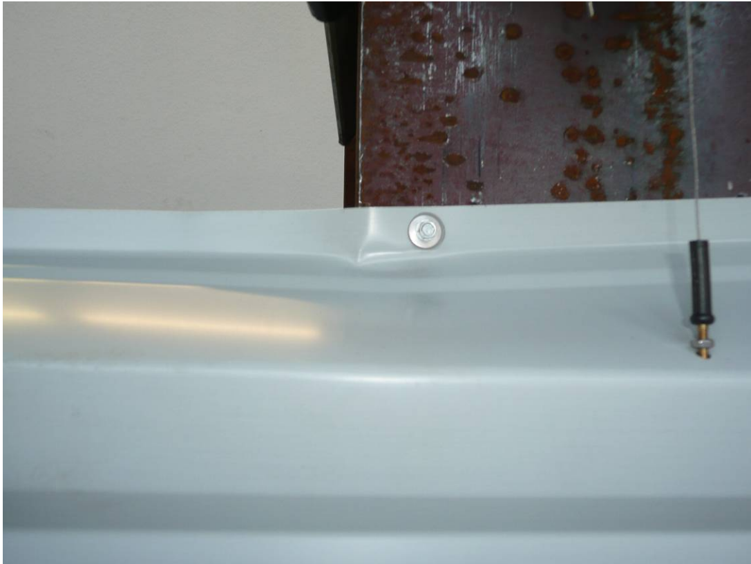
Abbildung A.155: Stegkrüppeln
