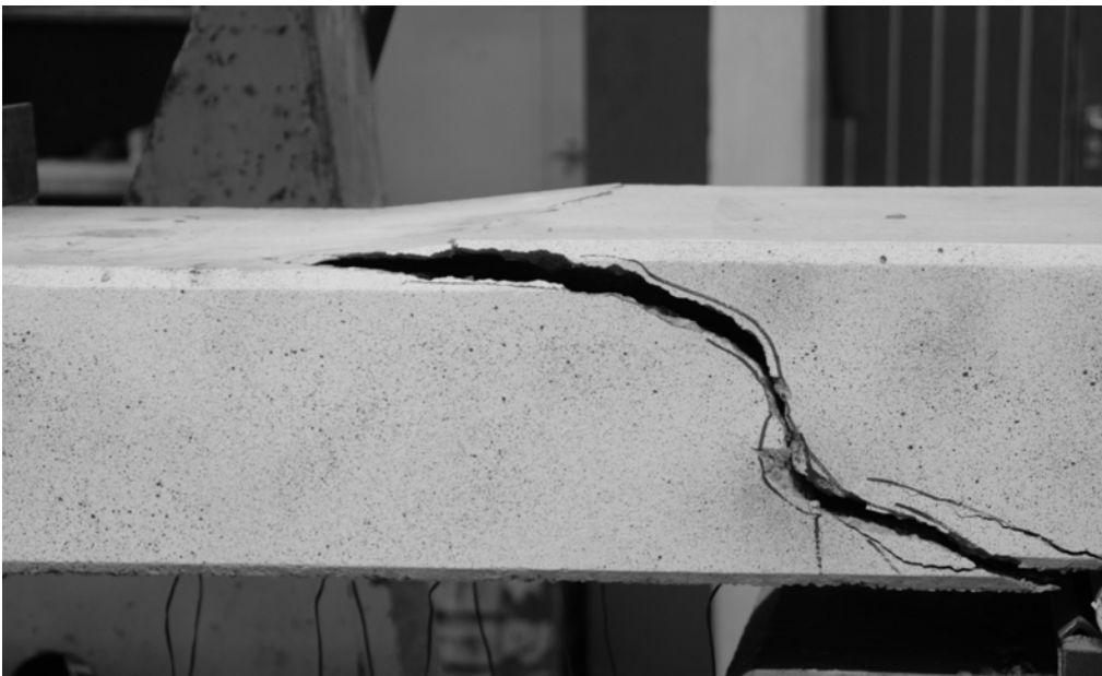
Bild 3.44: Versuch QVPA4-2 (Mit aufgeklebten CFK-Lamellen verstärkte Platte): Bruchbild
