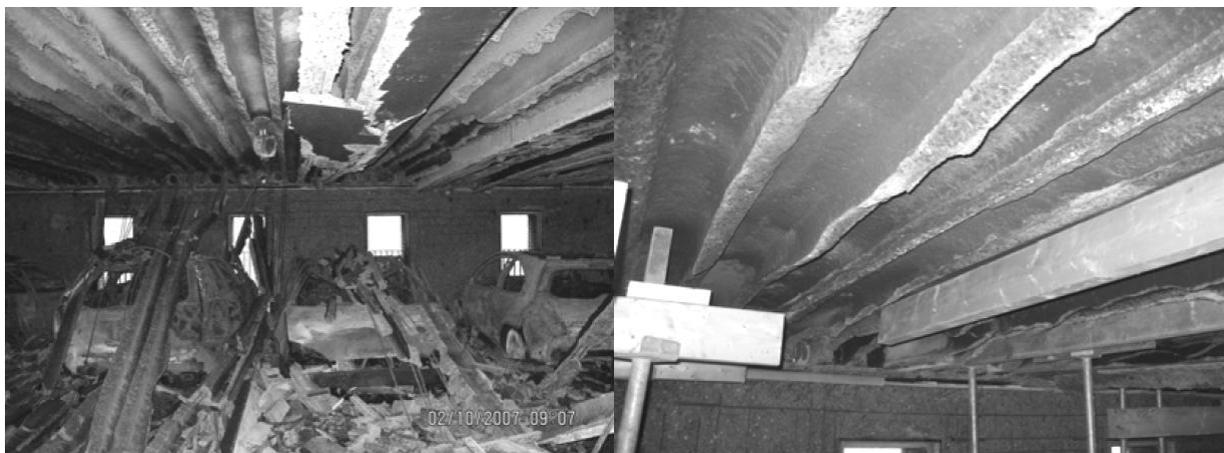
**Abbildung 3: Kollabierte Spannbetonhohldielen infolge Längsrissbildung in den Stegen [28]**
