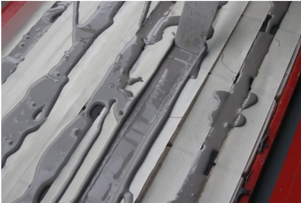
Bild 5: Einbringen eines selbstverlaufenden Fugendichtstoffes und bündiges Abziehen des überschüssigen Dichtstoffes mit einem Spatel mit den Flächen der Halterungen
