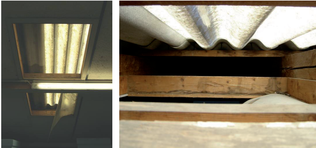
Abbildung 26 Einbausituation im Dach nach Ausbau der Probekörper
