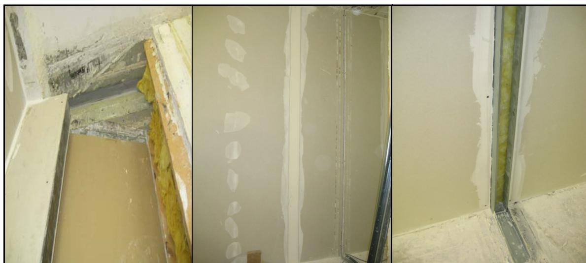
**Bild 19** Fotos zur GKB-Metallständerwand in Ziffer 6.2.1 (links - Stoßstelle durchgehend, Mitte - geschlitzt, rechts - unterbrochen)
