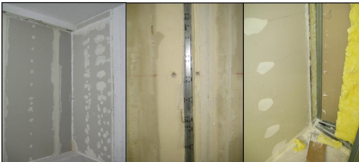
**Bild 12** Fotos zur GKB-Metallständerwand in Ziffer 6.1.1 (links - Stoßstelle durchgehend, Mitte - geschlitzt, rechts - unterbrochen)
