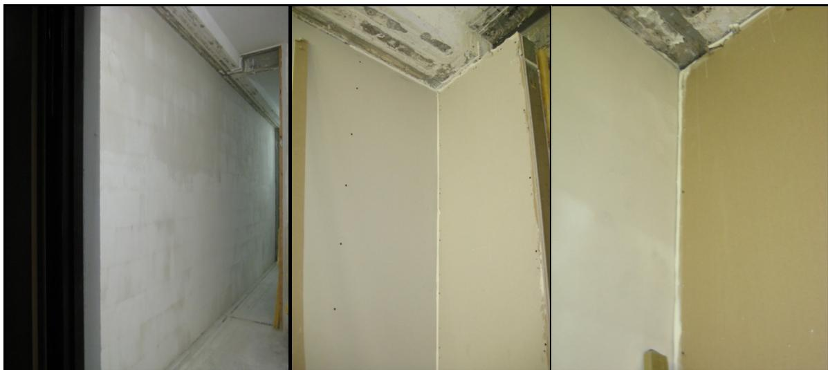
**Bild 25** Fotos zur Vorsatzschale an der schweren Massivwand in Ziffer 6.4.1 (links – schwere Massivwand ohne Vorsatzschale, Mitte - geschlitzt, rechts - unterbrochen)
