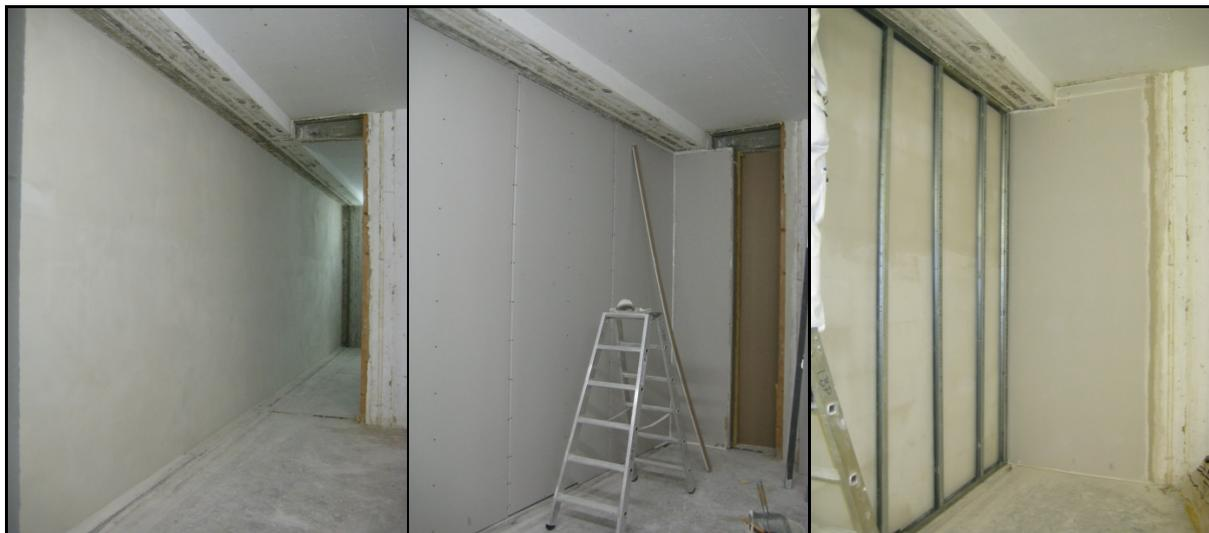
**Bild 23** Fotos zur Vorsatzschale an der leichten Massivwand in Ziffer 6.3.1 (links – leichte Massivwand ohne Vorsatzschale, Mitte - geschlitzt, rechts - unterbrochen)
