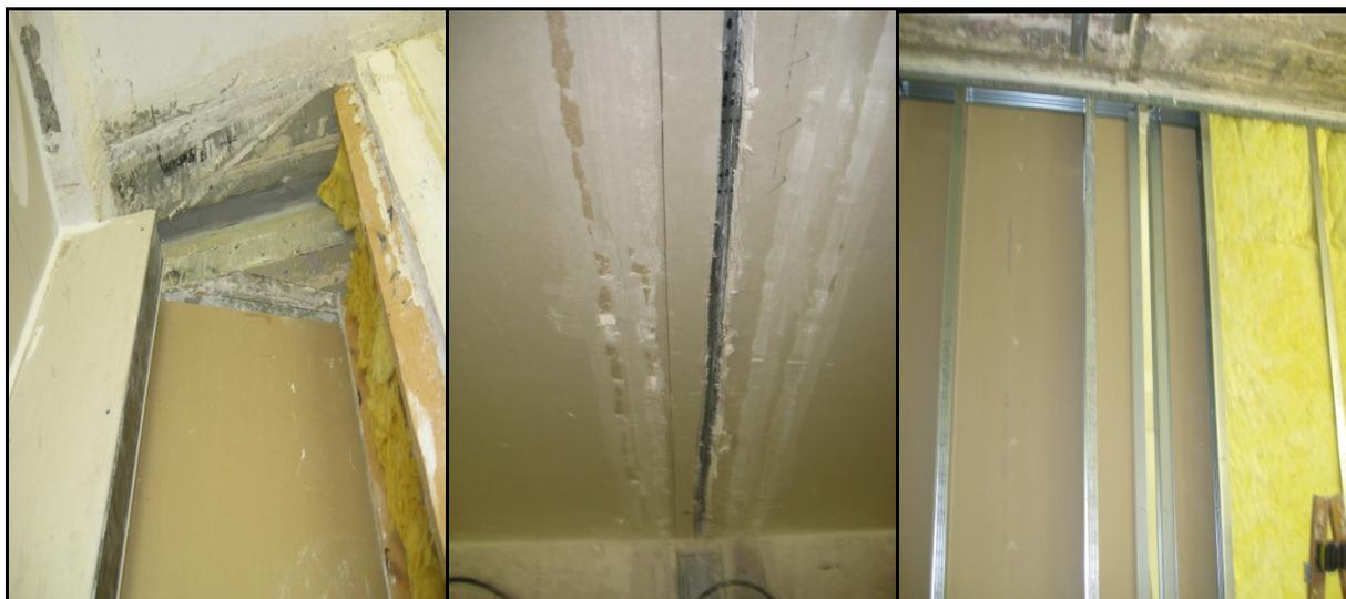
**Bild 21** Fotos zur GKB-Metallständerwand in Ziffer 6.2.2 (links - Stoßstelle durchgehend, Mitte - geschlitzt, rechts - unterbrochen)
