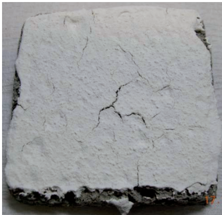
Abbildung 42: Verputzte Papierplatte ohne Vorbehandlung. Nach dem Trocknen sind tiefe Risse auf der gesamten Oberfläche erkennbar.
