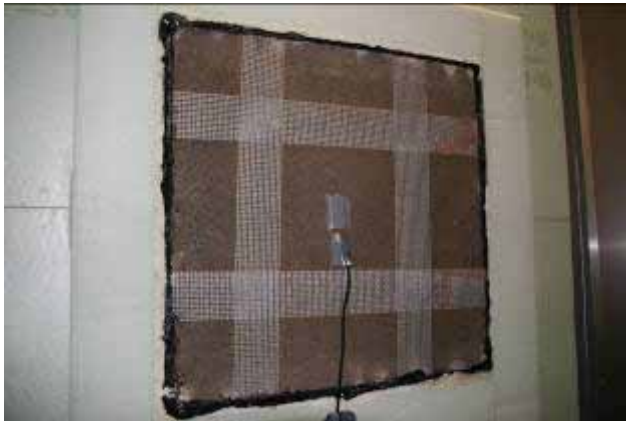
Abbildung 26: Kaltseite Probenkörper, Betonoberfläche nach dem Befeuchtungsexperiment
