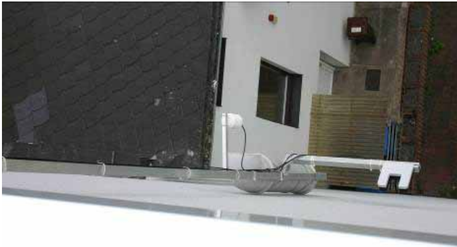
Schlagregenmessung vor der Fassade
