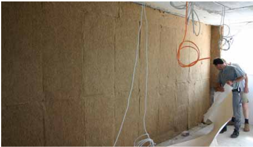
89 Hanffaser-Dämmmatten als Ausgleichsschicht
