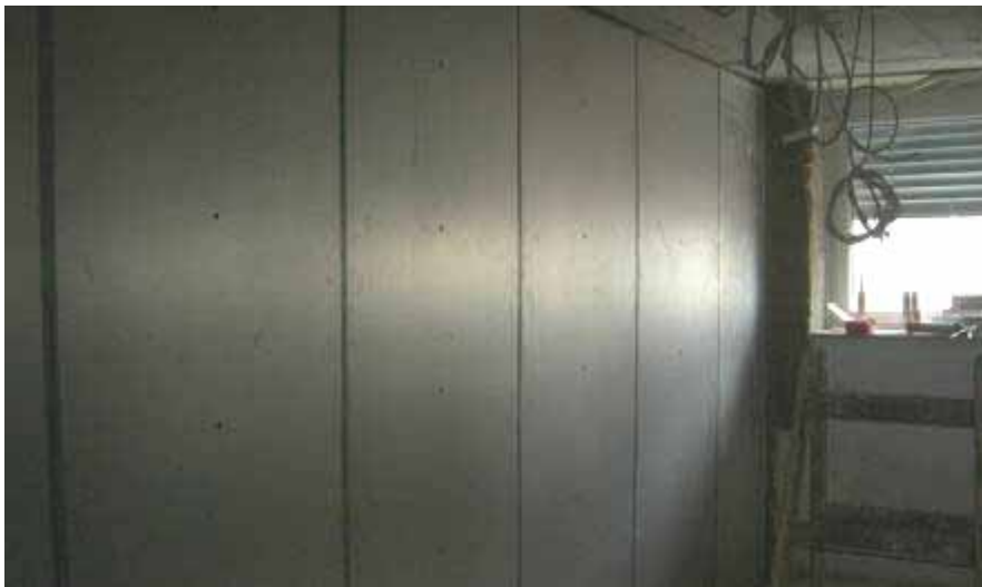
Wandflächen-Paneele in Position
