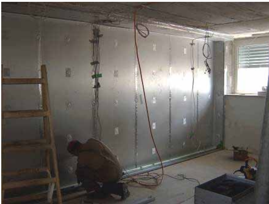
Montierte Begleitdämmung, Vorbereitung der Vorsatzschale
