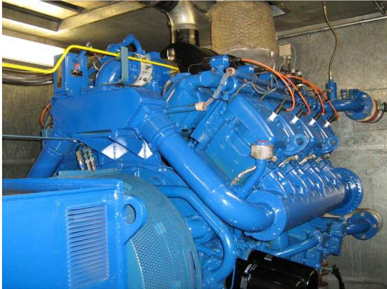
**Abbildung 22: BHKW-Modul Anlage 5**
