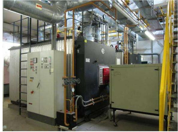
**Abbildung 30: BHKW-Module (links) und Spitzenlastkessel (rechts) Anlage 12**
