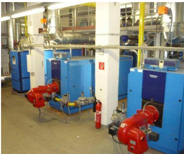
Abbildung 34: BHKW (links) und Spitzenlastkessel (rechts) Anlage 16
