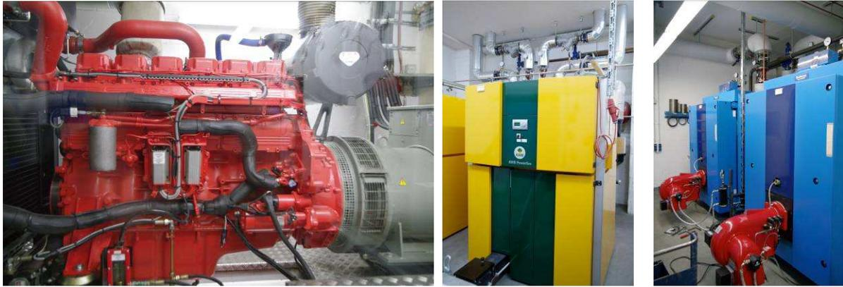
**Abbildung 21: BHKW-Modul, Hackschnitzelkessel und Spitzenlastkessel Anlage 4 (von links)**
