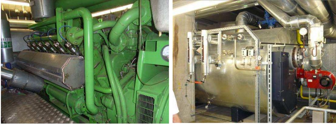
**Abbildung 32: BHKW-Modul (links) und Austreiberkessel (rechts) Anlage 14**
