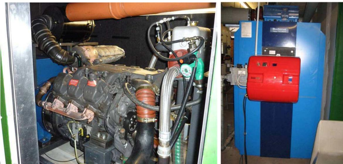
Abbildung 35: BHKW-Modul (links) und Spitzenlastkessel (rechts) Anlage 17
