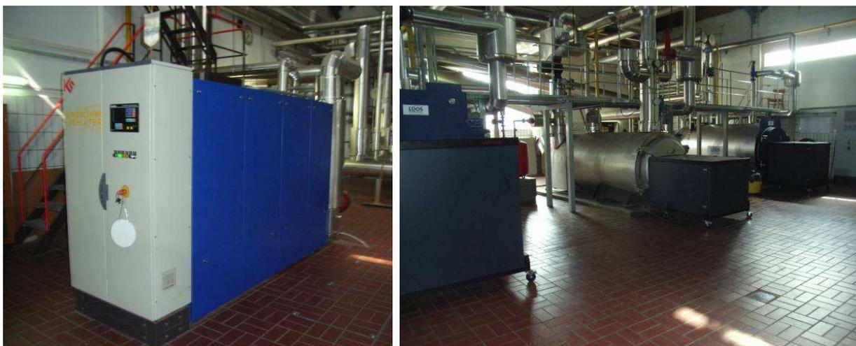
Abbildung 29: BHKW-Modul (links) und Spitzenlastkessel (rechts) Anlage 11
