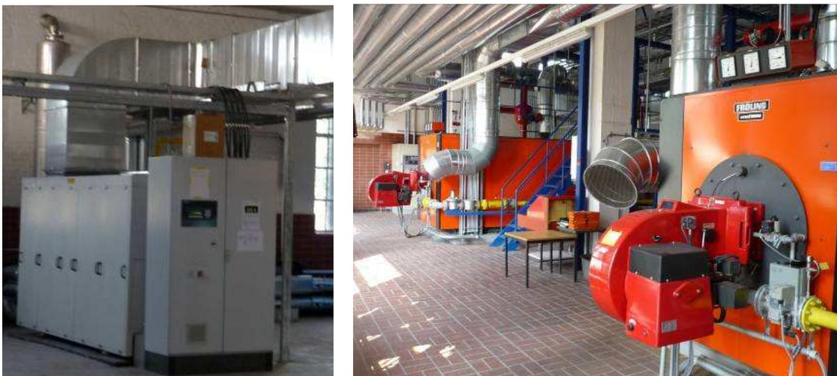
**Abbildung 33: BHKW-Modul (links) und Spitzenlastkessel (rechts) Anlage 15**
