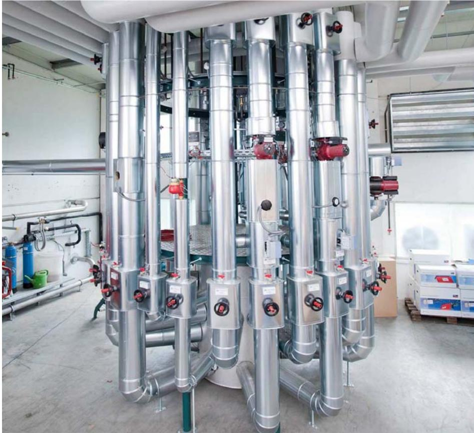
**Abbildung 10: Mehrstufiger Zortström-Verteiler für ein Fernwärmenetz mit multivalenter Heizanlage [Bildnachweis: Burkhardt GmbH]**
