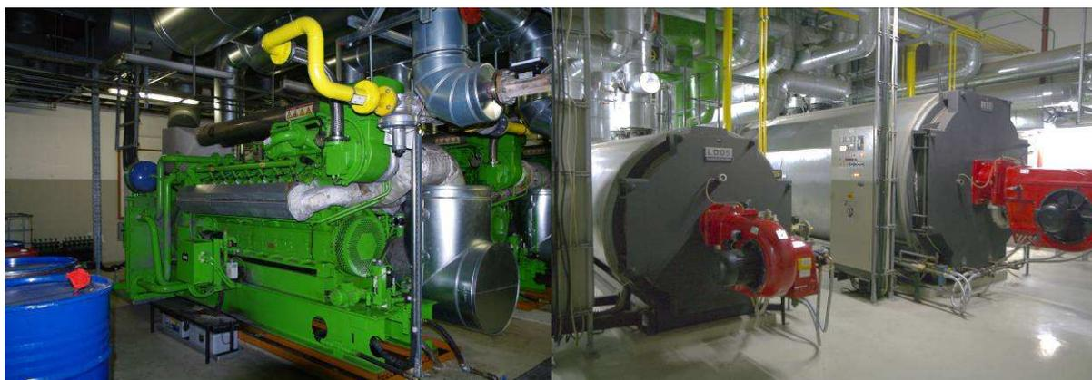
**Abbildung 20: Biomethan-BHKW-Modul (links) und Spitzenlastkessel (rechts) Anlage 2 und 3**
