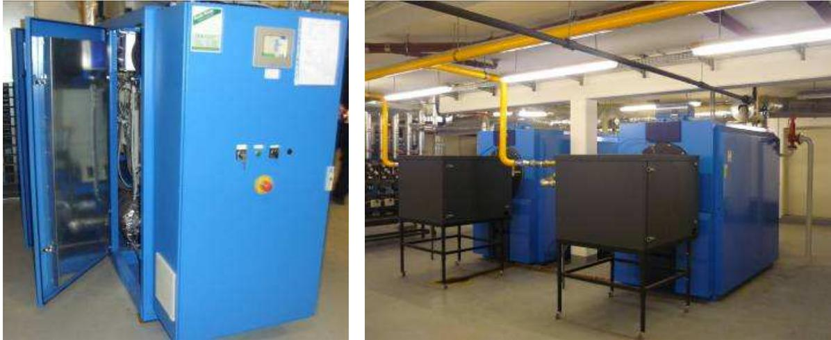
Abbildung 28: Von links: BHKW-Modul (links) und Spitzenlastkessel (rechts) Anlage 10
