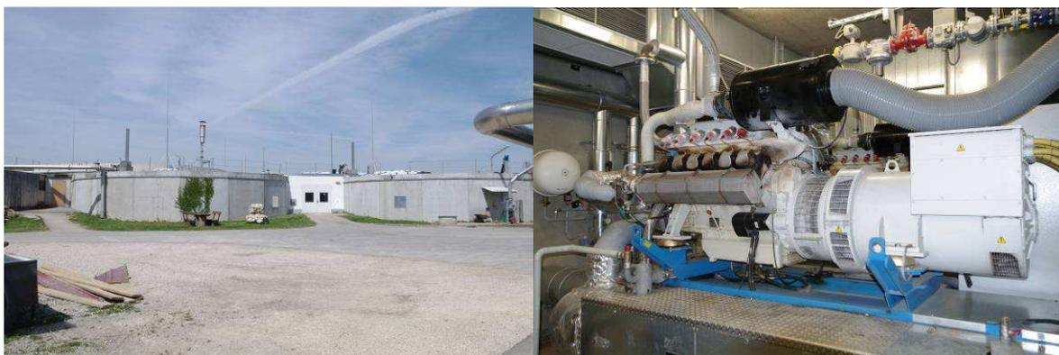
Abbildung 23: Fermenter (links) und BHKW-Modul (rechts) Anlage 7
