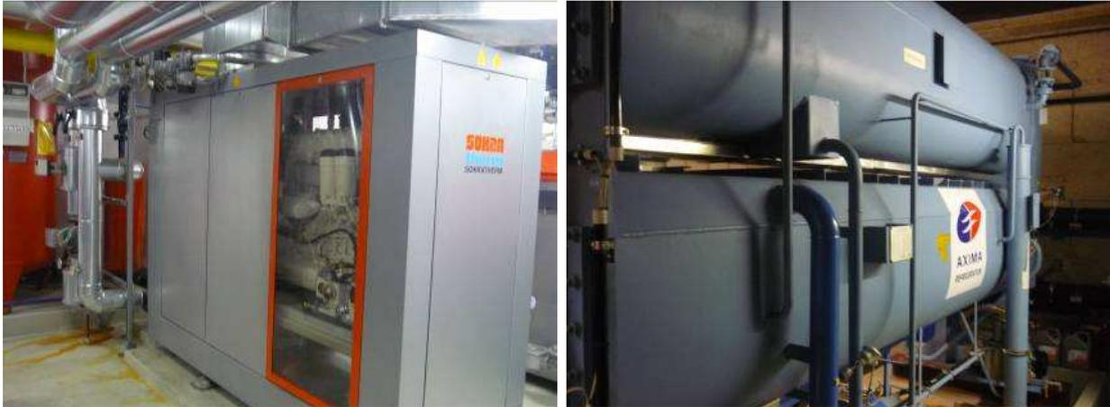
Abbildung 27: BHKW-Modul (links) und Absorptionskälteanlage (rechts) Anlage 9
