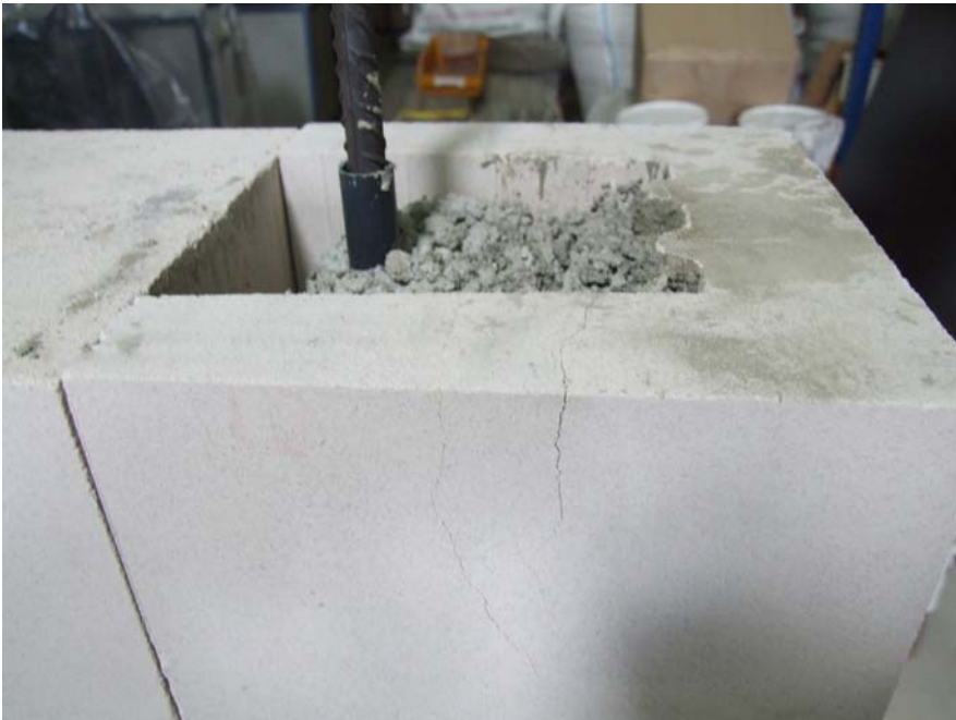
Bild B67: Untersuchungen an vertikal angeordneter Bewehrung in großen Aussparungen, Versagensbild der Versuchsserie mit Kalksandsteinen und Beton C25/30, Bewehrungsdurchmesser d_s = 14 mm
