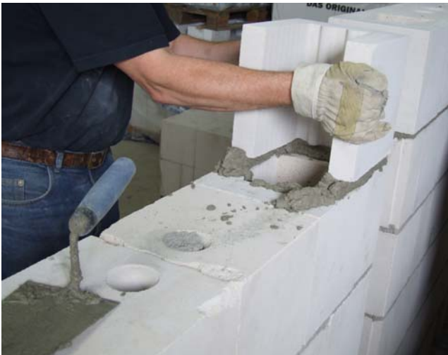
Bild B58: Untersuchungen an vertikal angeordneter Bewehrung in großen Aussparungen, Herstellung der Prüfwände mit gegenläufiger Anordnung der U-Schalen
