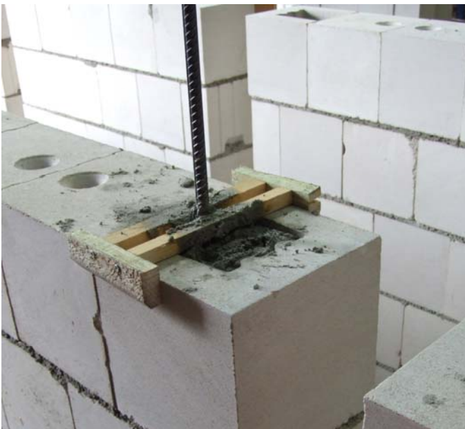
Bild 21: Prüfkörper zur Bestimmung des Verbundverhaltens an vertikaler Bewehrung in großen Aussparungen
