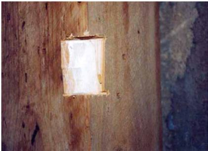
Abb. 5: Entnahmestelle einer Holzprobe aus einem Ständer im Dachgeschoss für die Untersuchung auf mögliche Holzschutzmittelbelastung
