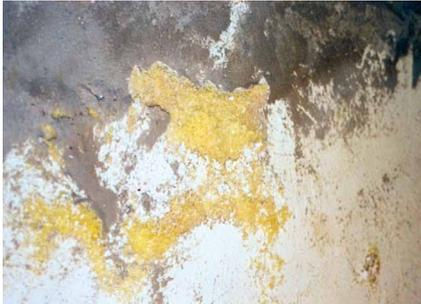
Abb. 4: Detail einer Innenwand mit flächigen Salzausblühungen, wo eine Probe für eine Untersuchung auf mauerwerkschädigende Salze entnommen wurde.
