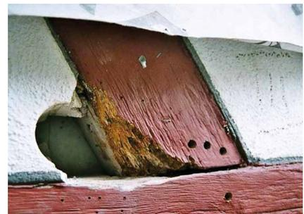
Abb. 3: Bohrkern-Endoskopie im Holz und Bohrkernentnahme im Gefach, z. B. für die Feuchtemessung
