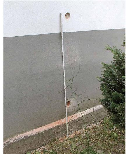
Abb. 1: Entnahmestellen von Mauerwerksproben durch Bohren (Anlegen einer Bohrachse), z. B. für die Feuchte- und Salzanalyse
