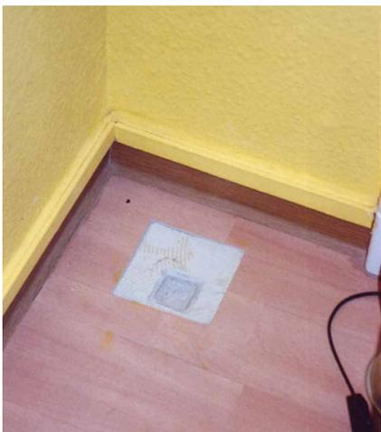
Abb. 6: Hier wurde eine Probe aus dem Fußboden in einer Wohnung entnommen zur Untersuchung der einzelnen verbauten Materialien auf Schadstoffinhalte aufgrund von Geruchsbelästigungen
