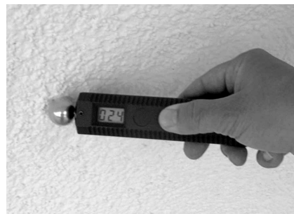
Abb. 6: Beurteilung der Feuchtigkeitsverhältnisse in einer Fassade mit einem elektrischen Messgerät
