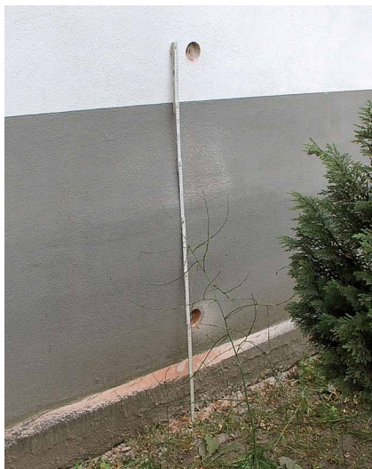
Abb. 1: Sondierungsbohrungen an einem Gebäude zur Ermittlung des Wandaufbaus und zur Bestimmung eines Feuchtigkeitsprofils
