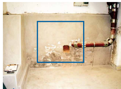
Abb. 7: Lage Messfeld (blaue Kennzeichnung) an der zu untersuchenden Kellerwand
