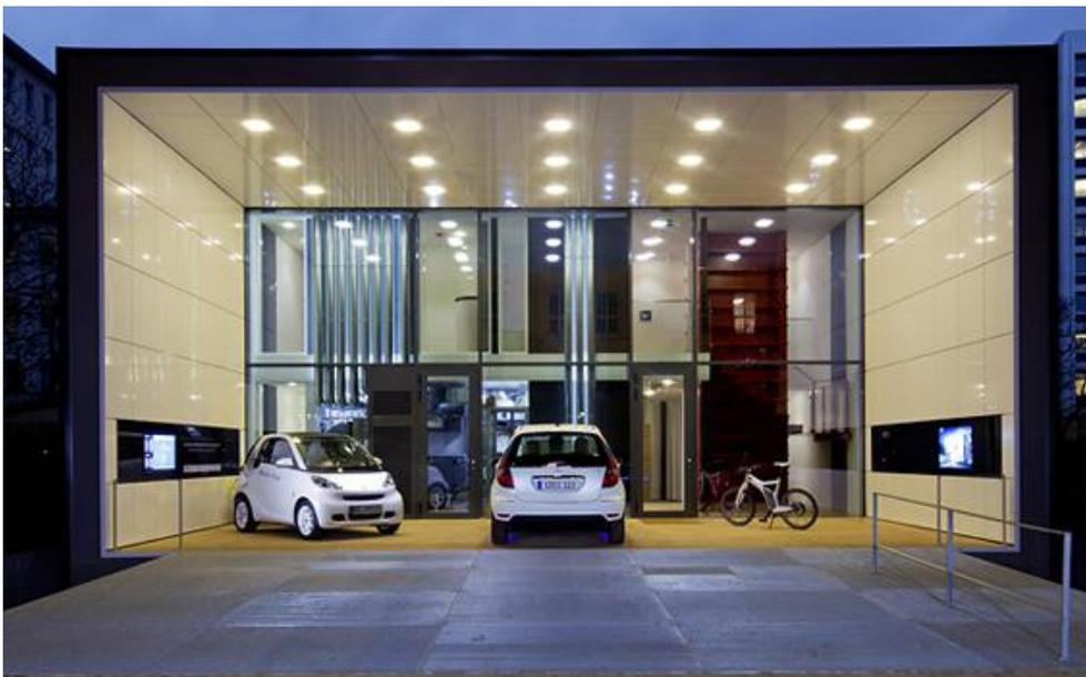
Abb. 99 Effizienzhaus-Plus in Berlin. Neben einer Induktionsladeplatte vor dem Gebäude (mitte) können die Wagen auch konduktiv (links) geladen werden; Quelle: BMVBS
