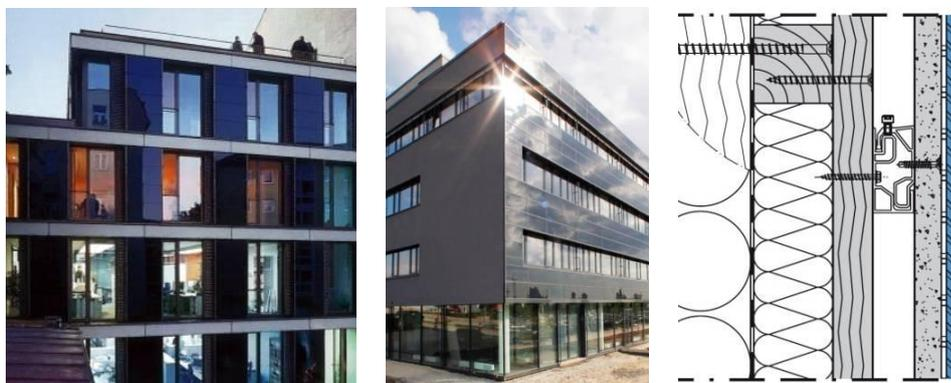
Abb. 46 Bild links: PV-Fassadenintegration in ein Wohn- und Bürogebäude; Quelle: B. Weller, Photovoltaik, Edition Detail; Bild mitte: PV-Fassadenintegration, Fa. KACO Firmengebäude; Quelle: www.würthsolar.de; Detail rechts: Fassadendetail in Holzbauweise mit einer vorgehängten, hinterlüfteten PV-Fassade Quelle: www.würthsolar.de; bearbeitet durch FGee
