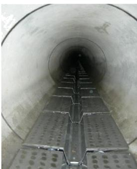
Abb. 47 Bsp. für einen Abwasserwärmetauschereinbau;
