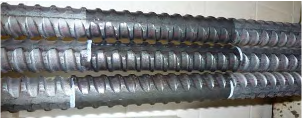
Abb. 4: Lackbeschichtung zum Abdecken des Durchführungsbereiches (150 mm)
