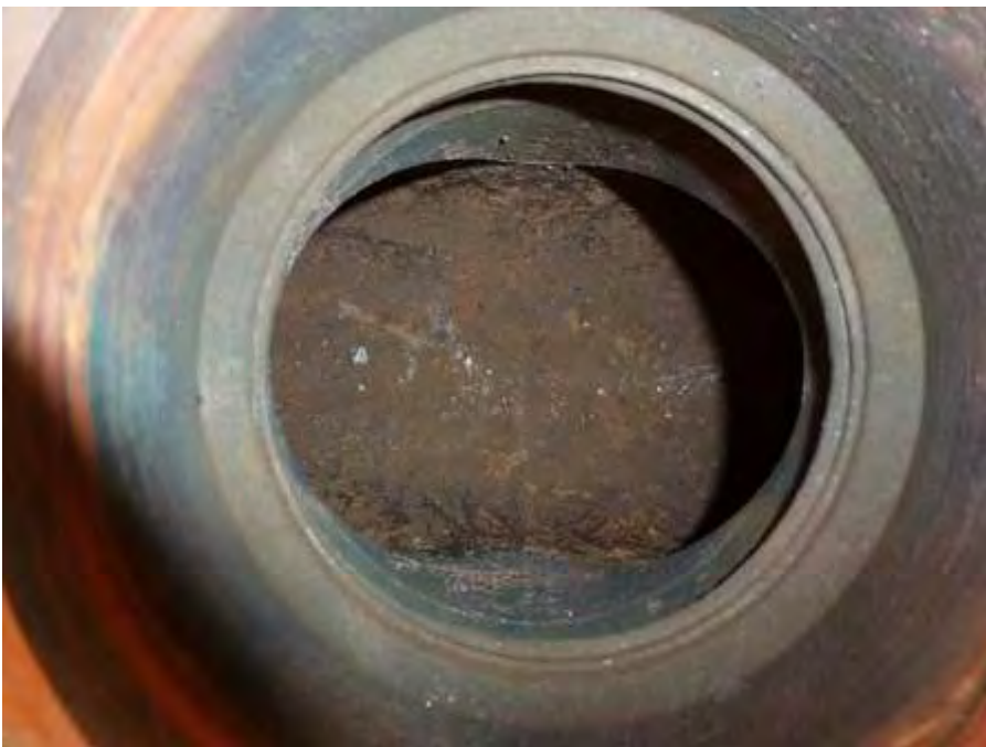
Abb. 11: Innenraum der Prüfkammer vor dem Füllen
