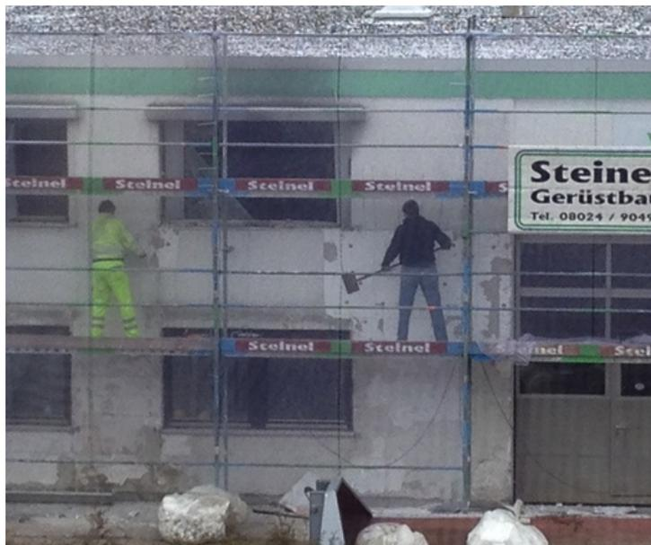
Abbildung 64: Entfernen der EPS-Platten mit einem Eisschaber. Die Dübelschäfte werden mit einem Bohrhämmer mit Meißel gelockert und von Hand herausgezogen (Quelle: FIW München)
