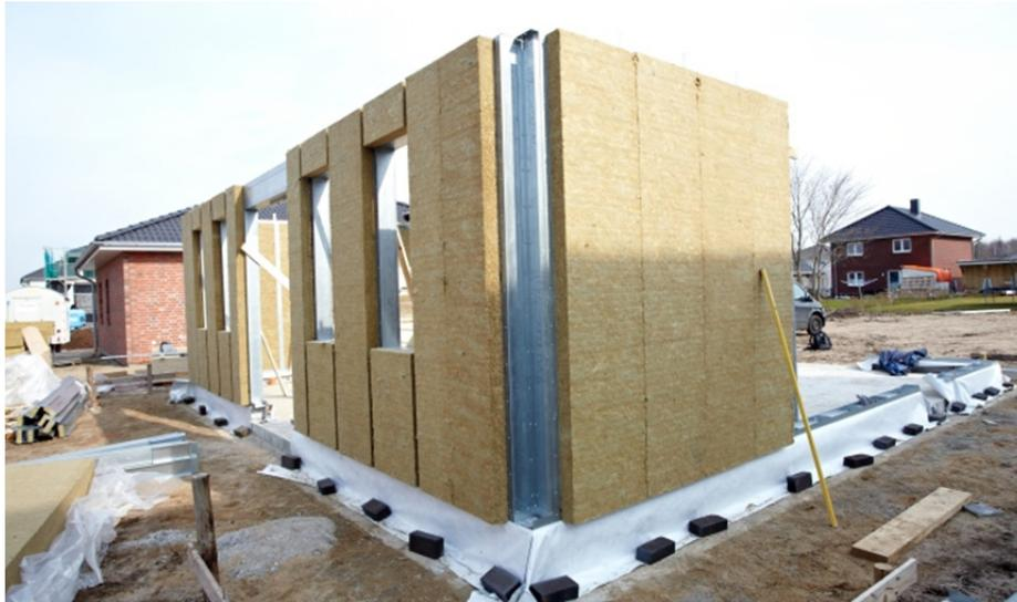
**Abbildung 46: Modulares Wandbausystem mit Mineralwolleplatten (RockShell, Rockwool)**
