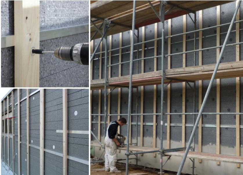
**Abbildung 47: Graues EPS in vorgehängten hinterlüfteten Fassaden bis zur Hochhausgrenze. Bild: BASF Pressemitteilung**
