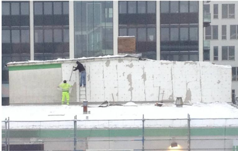
Abbildung 63: Abschalen der Putzschicht mit einem Eisschaber, Gräfelfing 2013 (Quelle: FIW München)
