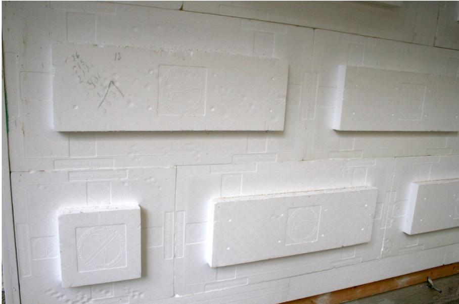
**Abbildung 49:** Erste Lage des Systems. Die Befestigung der ersten Lage erfolgt in den Plattenstößen mittels üblicher Dämmstoffdübel. Die Befestigungen werden durch eine zweite VIP-gedämmte Lage, den sog. LockPlates, überdämmt.
